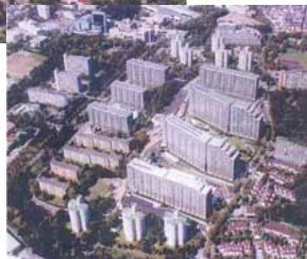
写真19 マンションの建替え事例(2)
