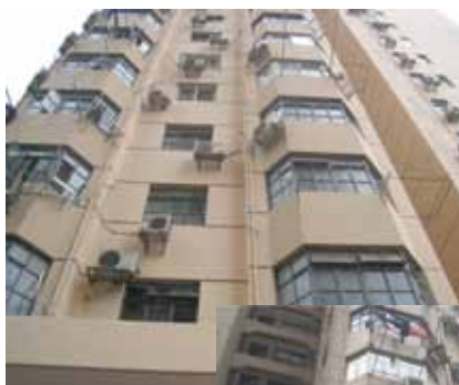
◀改修済みの棟
