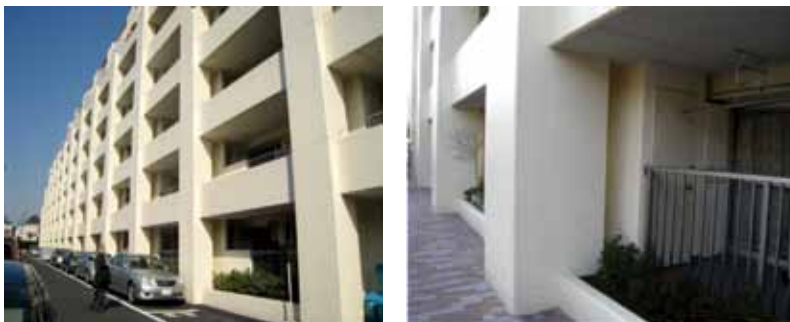
写真6 全面改修（外付けフレーム工法）
