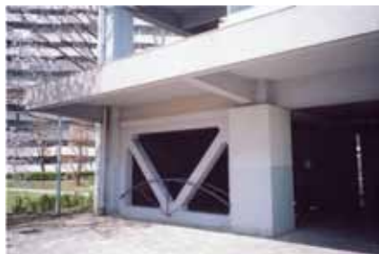
写真5 ピロティ部分鉄骨ブレース補強
