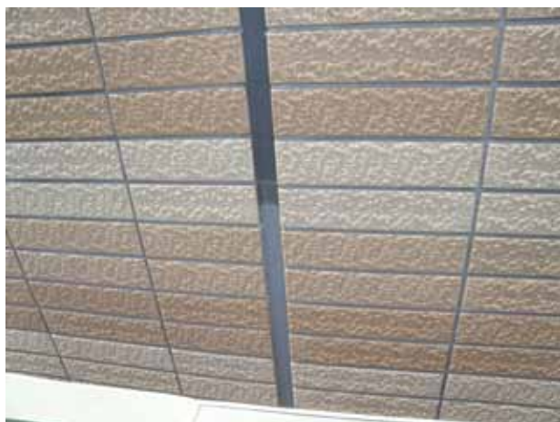
目地シーリングの途中から色が違う個所。何故このような事が起こりえるのか理解に苦しむ事象。
