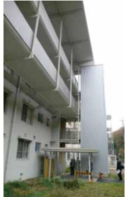
写真12 HCシステム（廊下を屋根より吊っている）
