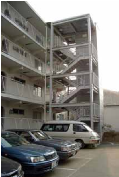
写真10 階段とエレベーターを一体化した例
