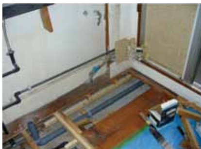
写真8 流し台床解体及び新規配管
