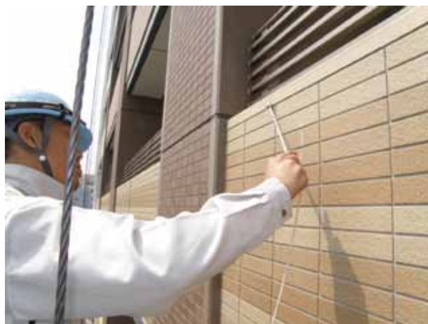
ゴンドラ調査の状況。タイルのひび割れや浮き、躯体の損傷状況を漏らさず記録。
