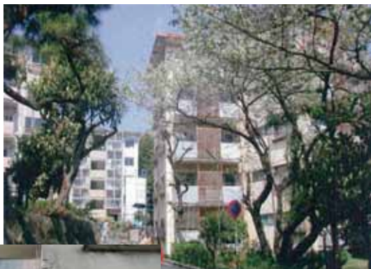
◀写真16 マンションの建替え事例（1）
