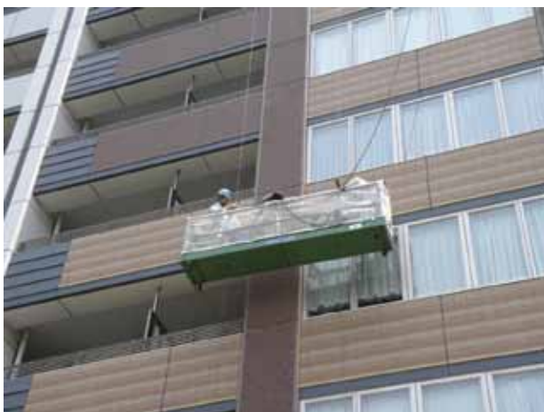
ゴンドラ調査の状況。調査者と記録者、コンサルの3名が同乗し状況を調査し記録。
