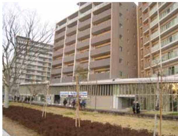
写真20 建替え後の建物外観
