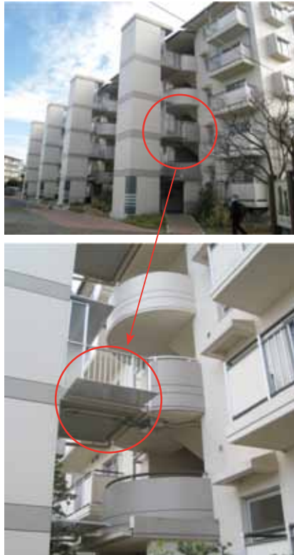
写真11 階段室に外付けでエレベーターを設置
