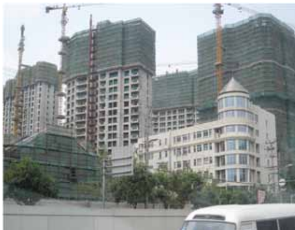
写真14 建設ラッシュの超高層マンション
