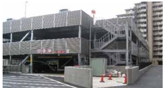
写真13 建替え後の駐車場
