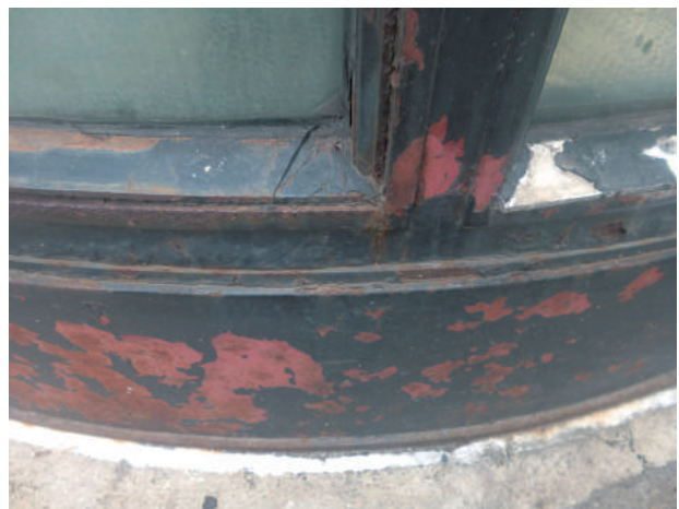
写真2 フラット・アイアンビルの鋼製窓枠(2016年、撮影・星川氏)
