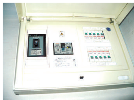
改修分電盤 (10回路の場合)
