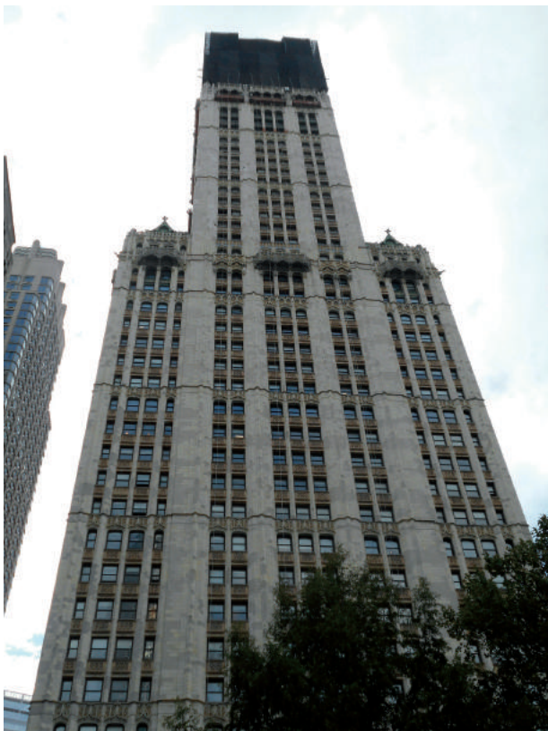
写真9 ウールワース・ビルディング外壁修繕工事中（2016年、筆者が撮影）
