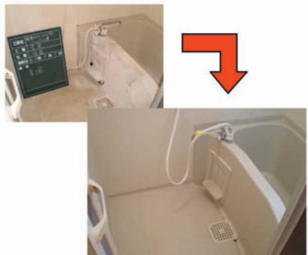
写真2 塗装によるリニューアル
