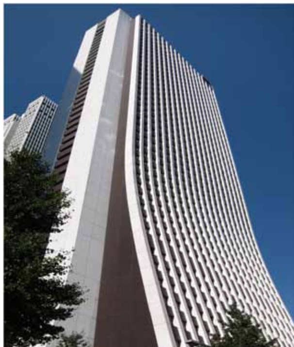
超高層オフィスビル
