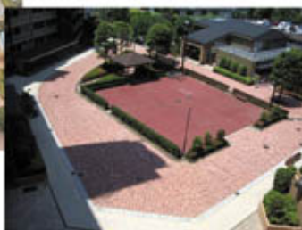
改修後の外構舗装部
