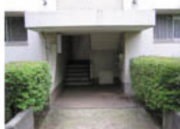
改修前の階段室入口全景
