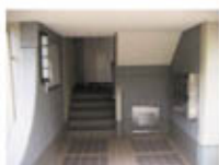
改修後の階段室入口内
