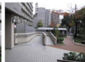
新設スロープ
