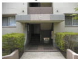
改修後の階段室入口全景
