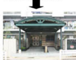
改修後のマンションエントランス廻り
