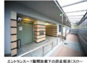
エントランス～1階開放廊下の段差解消（スロープ新設）
