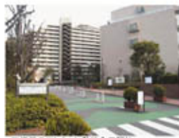
改修前のマンション敷地入口廻り
