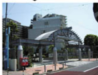
改修後のマンション敷地入口廻り
