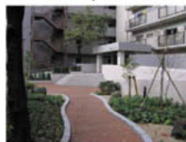
改修後のマンションエントランスアプローチ
