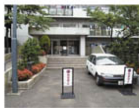
改修前のマンションエントランスアプローチ
