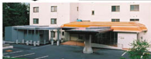
改修後のマンションエントランス廻り
