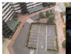
改修前の外構舗装部
