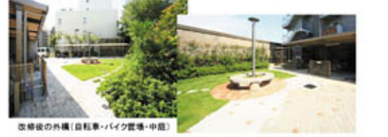
改修後の外構（自転車・バイク置場・中庭）
