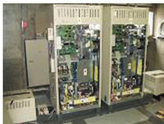
新型制御盤取替え工事中
