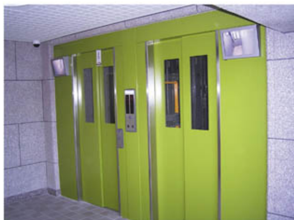
全撤去方式により取り替えたエレベーター
