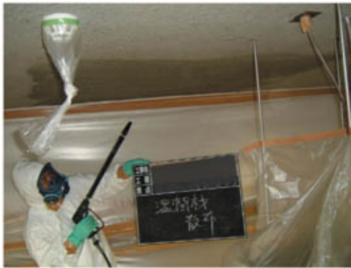
アスベスト除去作業の様子
