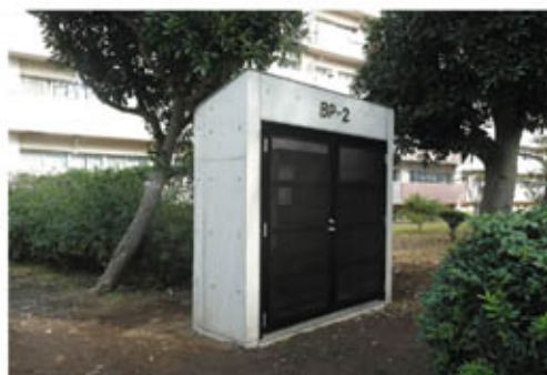
写真9 ブースターポンプ置き場—RC打ち放し、アルミパンチング扉、屋根無し
