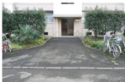
写真1 アプローチ改修〈工事前〉
