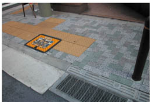
写真6 車道と歩道の摺り付け部—8種類の床材
