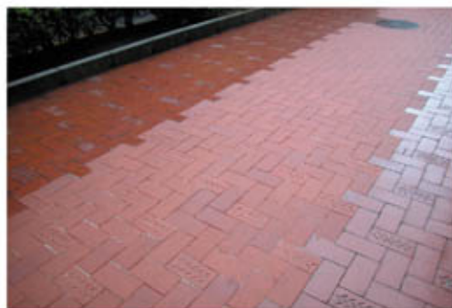
写真5 降雨時のインターロッキング舗装—中央の艶のない部分が透水ブロック
