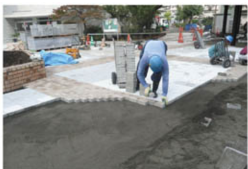
写真7 改修工事中の集会所前広場—インターロッキングブロック敷き詰め中
