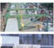
▲ゴンドラ自体をネットでおさうため、塗料の飛散・工具の落下も防ぎます。
