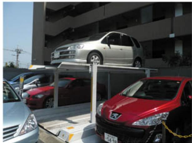
写真11 ピット型機械式駐車場
