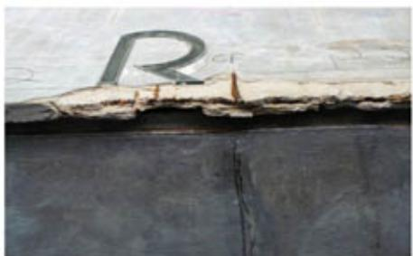
写真⑬ エントランス部上裏、先端部の水切溝付近に見られる錆鉄筋の露出。
