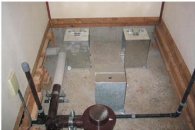
写真9、10 電気温水器の耐震固定事例
