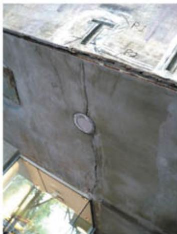
写真⑫ エントランス部付近、上裏面のひび割れと先端部に見られる錆鉄筋の露出。
