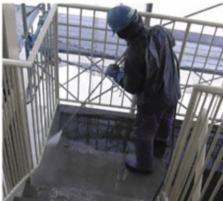
超高压洗浄機によるケレン洗浄
