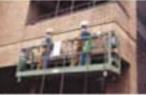
ゴンドラ足場とは、下から組んでいく足場とは異なり、屋上からワイヤロープで吊り下げたゴンドラを、電動で昇降させて作業を行うタイプの仮設足場です。日本ビソの仮設ゴンドラは集合住宅・一般建物を問わず建築物の外装工事作業に幅広く利用されています。
