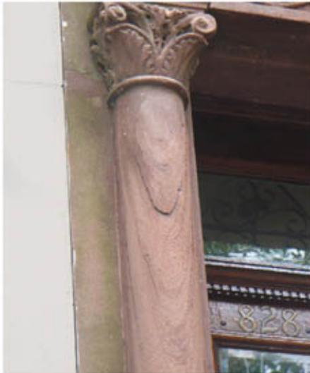
写真⑩ 石目に沿って生じた割れ。ブルックリンのクラウン・ハイツ地区の建物（2011年に筆者が撮影）。
