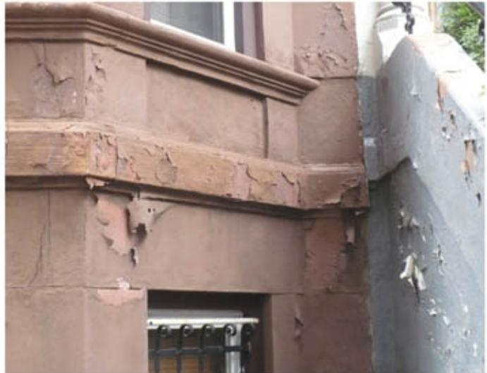
写真⑪ 石の上に施された塗装の剥がれ。ブルックリンのクラウン・ハイツ地区の建物（2011年に筆者が撮影）。
