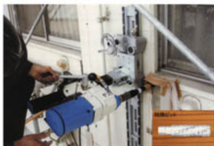
写真26 耐震補強の工法（耐震スリット）
