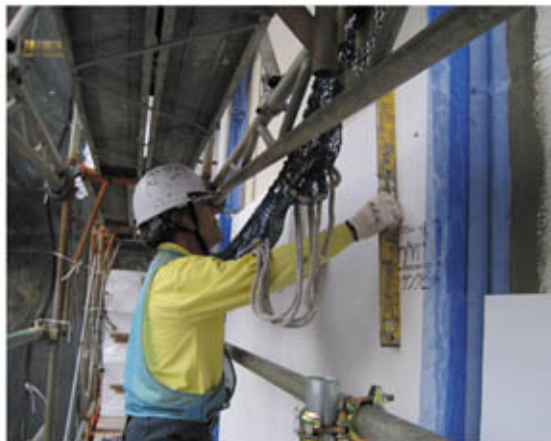
断熱材張りの施工状況
