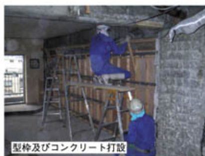
写真25 耐震補強の工法（RC耐震壁）
