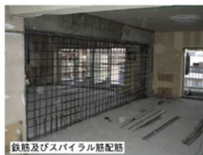
写真25 耐震補強の工法（RC耐震壁）
