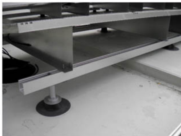
架台回りの防水処理
