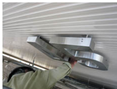
棟番号は支持金物から取替え
