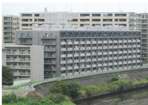
写真29 耐震補強の工法（ブレース工法）
