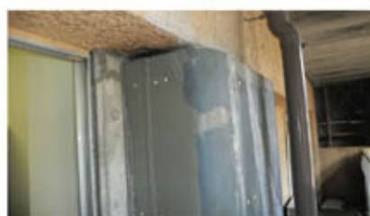
写真27 耐震補強の工法（柱鋼板巻き）
