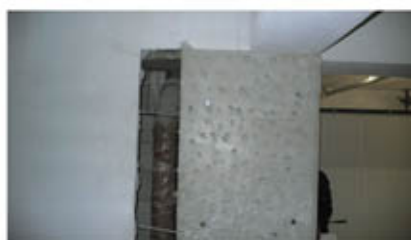
写真27 耐震補強の工法（柱鋼板巻き）
