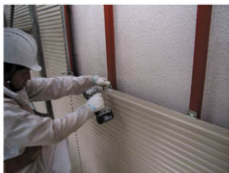
下地金物と外装材 (写真は断熱材がありません)
