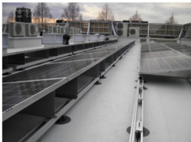
太陽電池パネル架台と屋上防水
