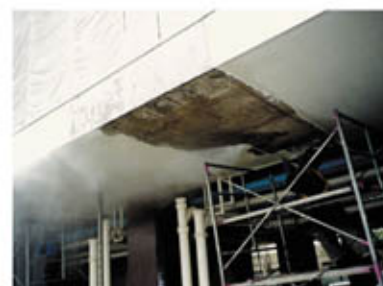
底上げ裏の高圧水洗浄(完全ケレン)
