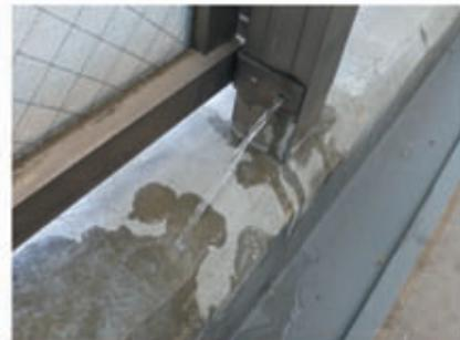
㉔ 手摺支柱下部に穴を開けると水が飛び出てくる
