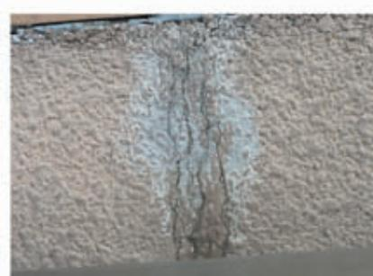
⑭ シーリングの上に塗られた塗装のひび割れ
