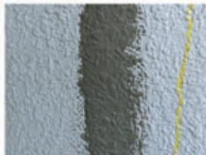
ひび割れのフィラー処理補修
