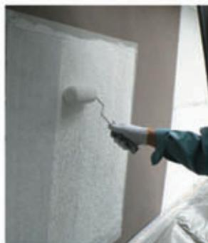
外壁塗材の塗布作業
