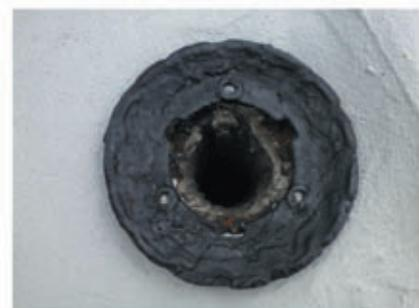
㉓ ビスが外せず、ビスを切断したものが見られる
