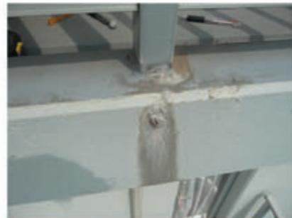
㉓ 手摺支柱付根からエフロレッセンスが析出している
