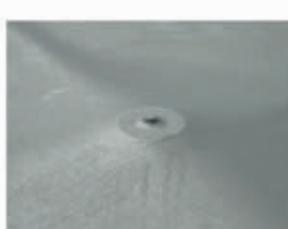
アンカー飛び出しによるシートの破損
