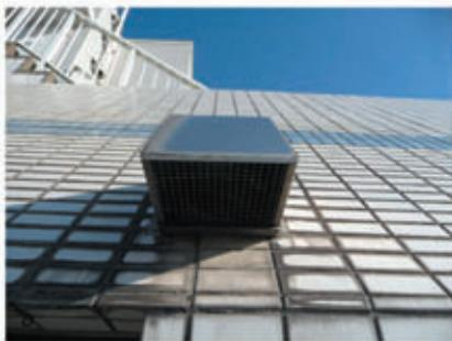
⑯ 金物周囲に使われたシリコーンシーリングによる外壁汚染
