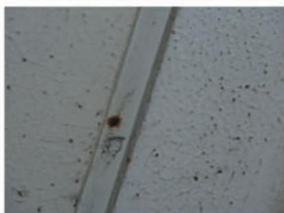
① 目地底の鉄筋が被り厚不足で錆びている
