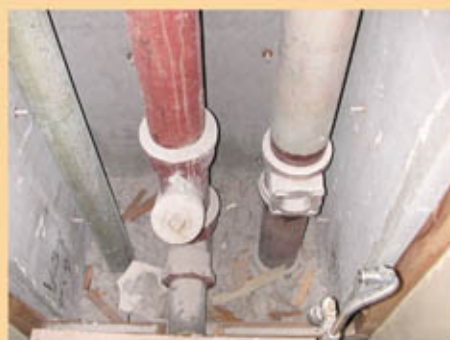
改修前（通気管・汚水管・雑排水管）
