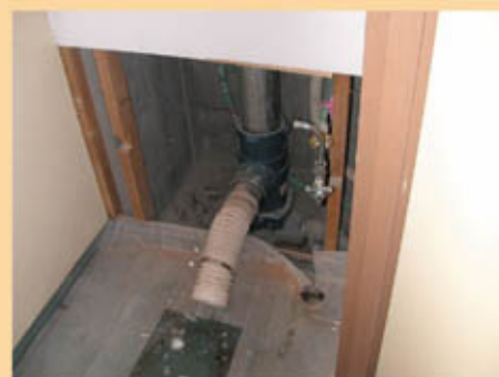
改修後（特殊継手排水システム排水管）
