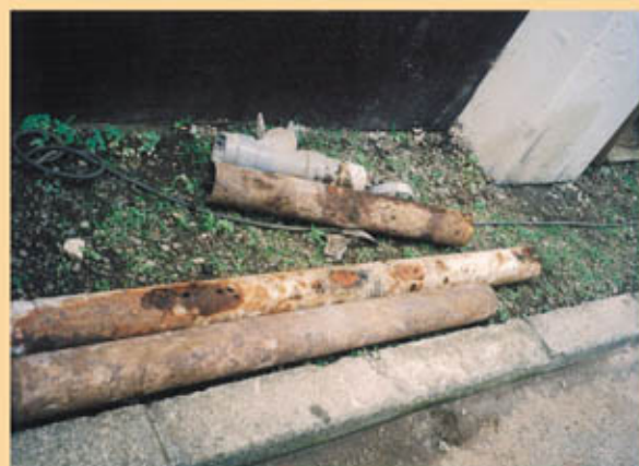
土中に埋設された亜鉛メッキ鋼管
