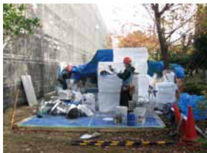
断熱材ストックヤードと加工場
