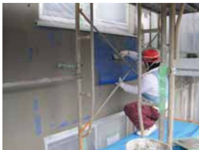
樹脂モルタル+メッシュ塗込み
