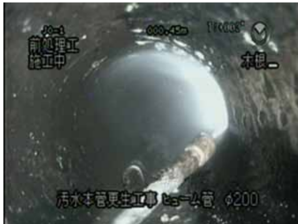
写真2 管内清掃状況
