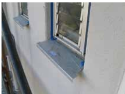
窓水切り新設試験施工（断熱材施工前）
