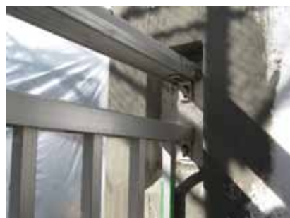
バルコニー手摺支持回りの断熱材の逃げ
