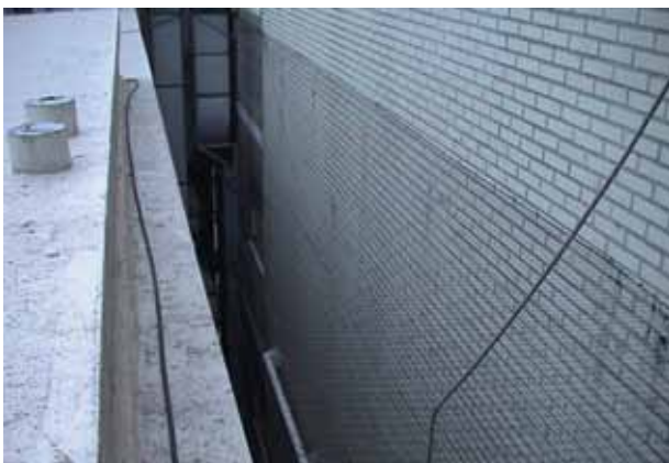
建物間へ設置
