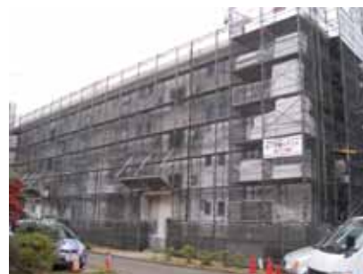
断熱材の貼付け
