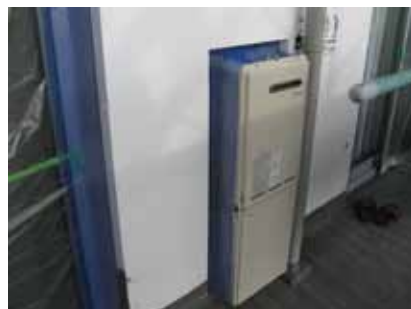
湯沸かし器を逃げて断熱材を張る
