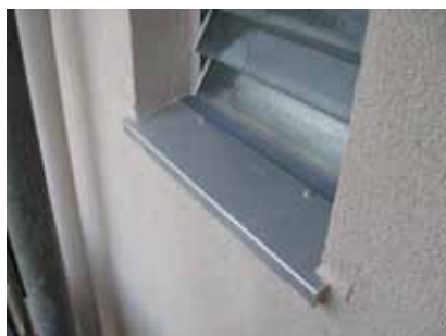
窓水切り新設（断熱材 50 mm 施工後）
