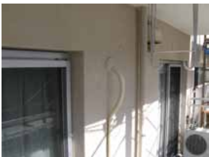
バルコニー開口・スリーブ回り
