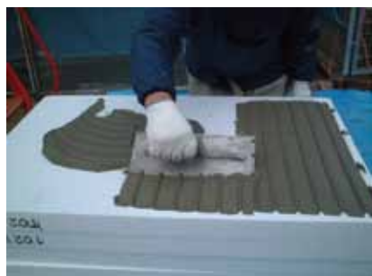
断熱材に接着モルタル塗り
