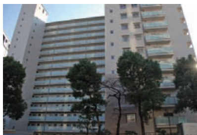
IPマンション北側補強面外観
