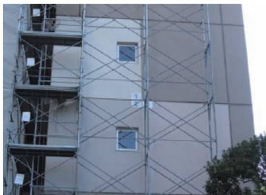
写真7 外壁塗装色アンケート用試験施工
