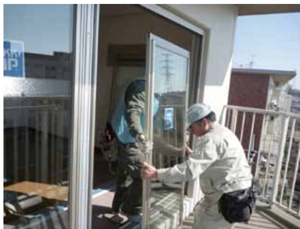
新規サッシ障子の吊込み
