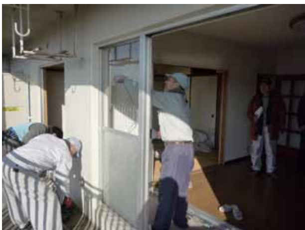
既存アルミサッシ障子の取外し
