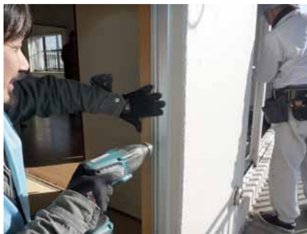
立枠下地材の取付け
