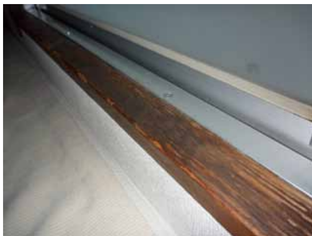
室内側木柵 (改修前)
