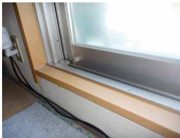
室内側木柵ラッピング処理
