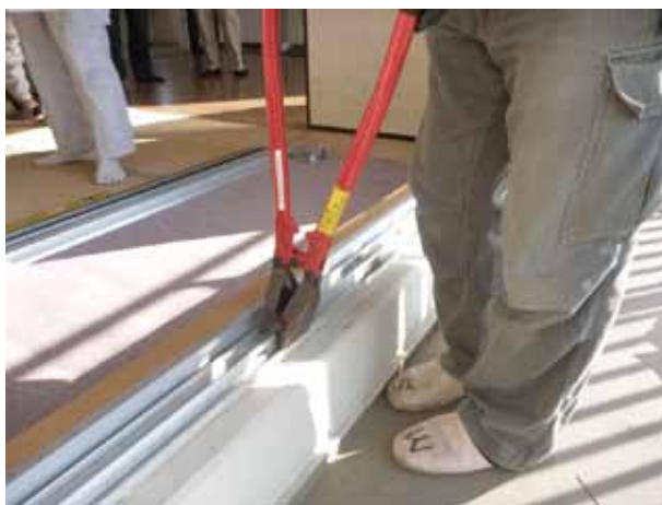
サッシ下枠レールのカット
