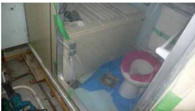
共用排水立て管を更新するときはお風呂もトイレも使えない。床や天井の解体も伴うので住戸内設備改修の機会となる。
