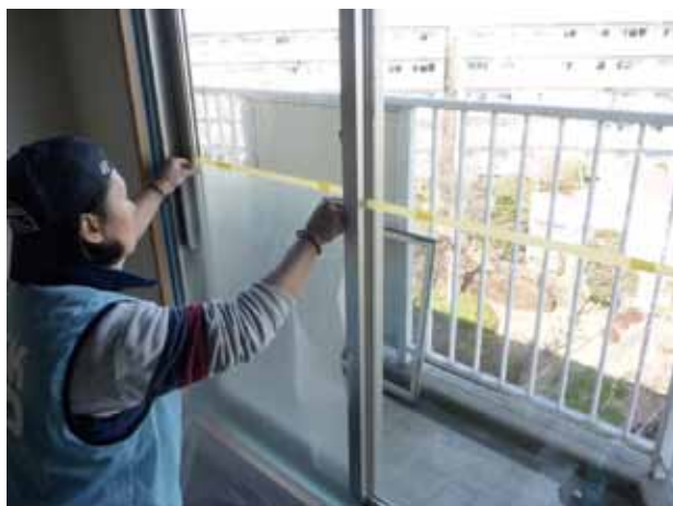
ガラスシェードフィルム張付け作業
