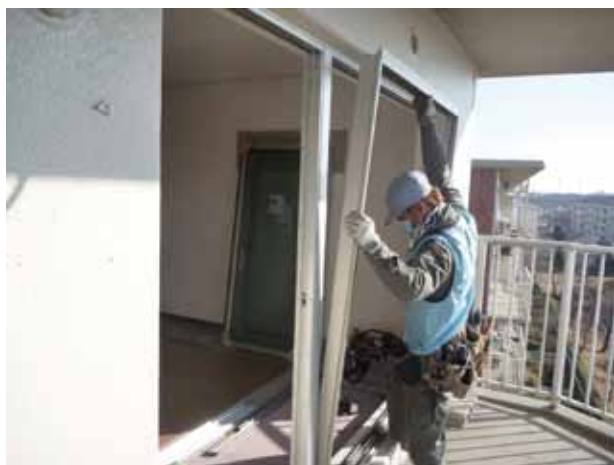
新規カバー枠の取付け
