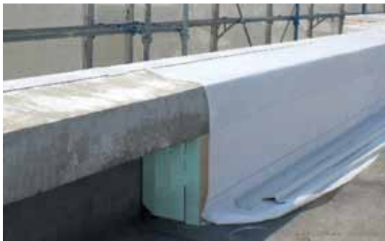
改修前（立上り部）
