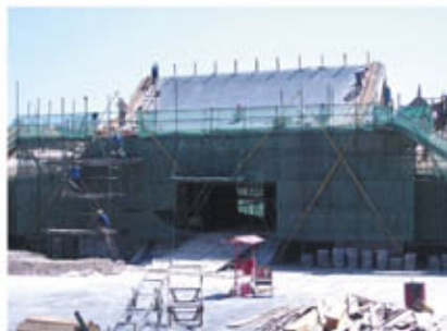
改修中の故宮
