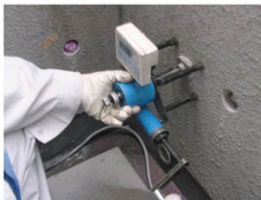
④ 引張試験機の設置
