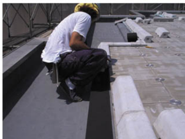
居室屋根を外断熱ブロック押えに、大庇屋根を露出仕上げとし、境界に縁石ブロックを敷設しているところ
