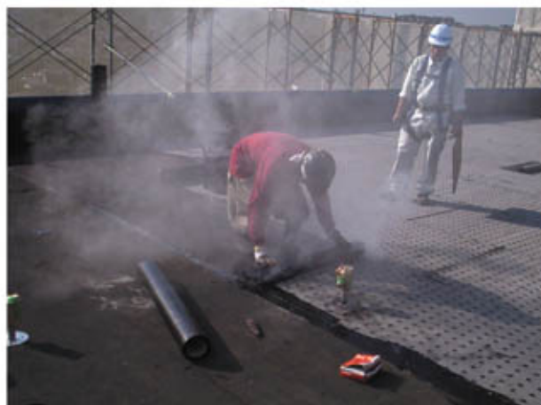
全面撤去工法で改質アスファルト防水熱工法（露出絶縁仕様）を施工しているところ
