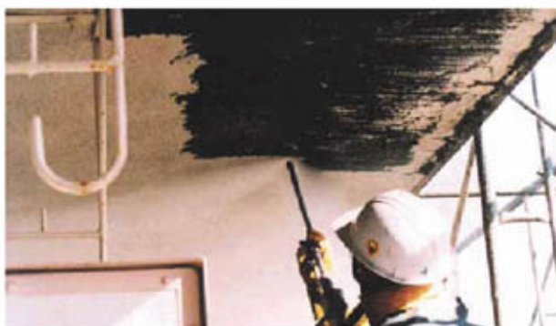
温水高圧洗浄によるバルコニー天井ケレン
