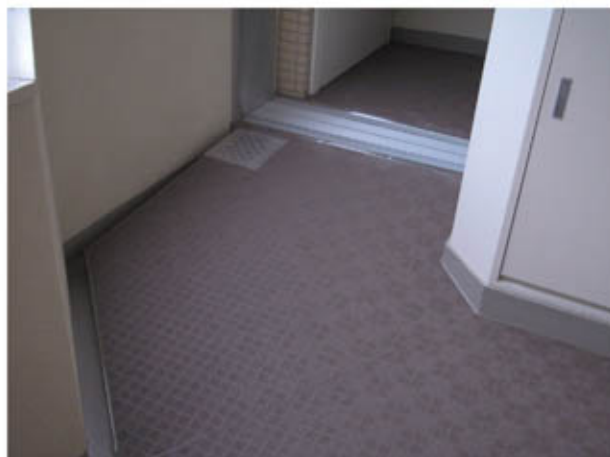
写真3 コンクリートを打設し本格的なスロープに改修。EXPJ金物とドレン点検蓋も新設した。
