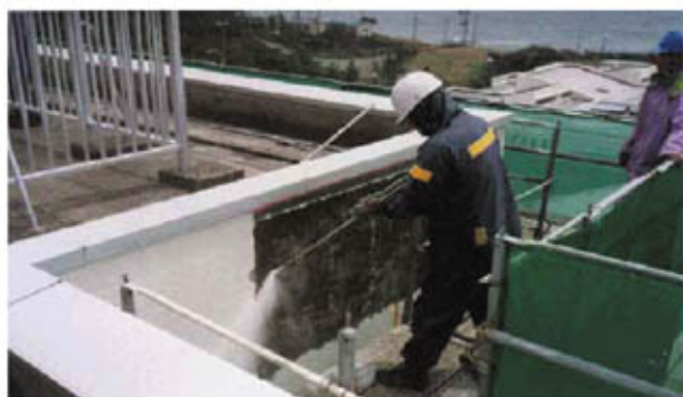
高圧洗浄による外壁塗膜ケレン
