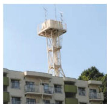
地震時に心配な高架水槽給水方式を直結増圧給水方式に変換
