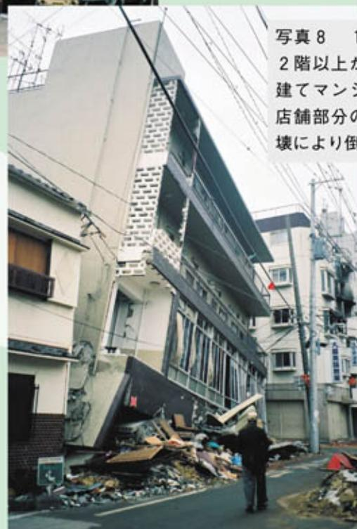
写真8 1階が店舗・2階以上が住戸の4階建てマンション。1階店舗部分の柱の座屈破壊により倒壊。
