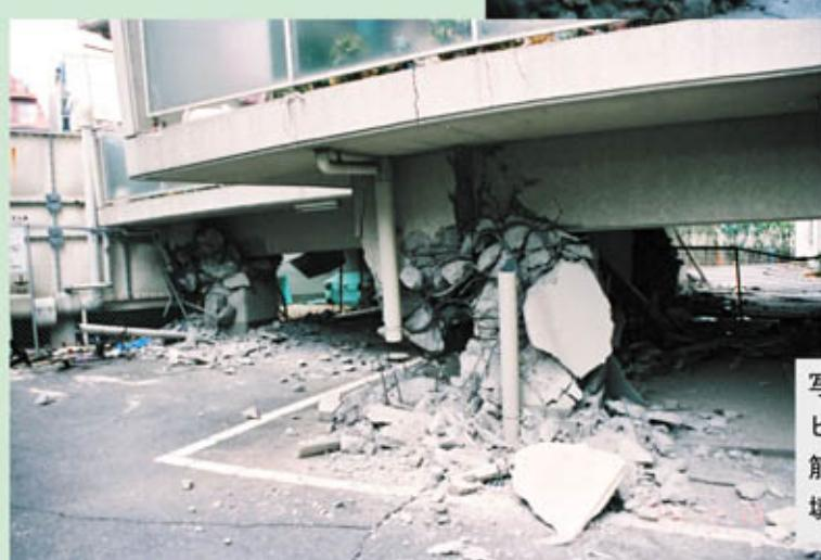
写真6 SRC造ラーメン構造の駐車場ピロティ型マンション。ピロティ柱の帯筋が細かく入っているため、完全な層崩壊は避けられた。
