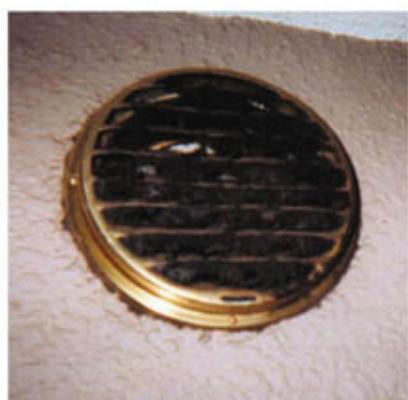
外壁面の台所換気扇・排気孔キャップの油汚れによる閉塞状況。
