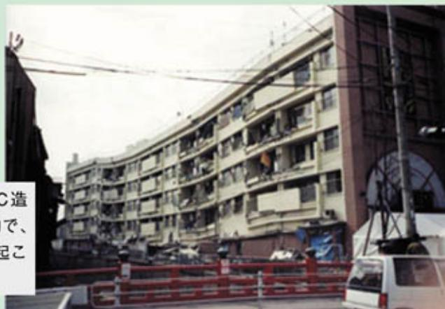
写真3 築後30年以上経過した旧耐震基準のRC造ラーメン構造の住棟。辺長比が大きい細長い建物で、1階の中央部分の柱がせん断破壊して層崩壊を起こしている。
