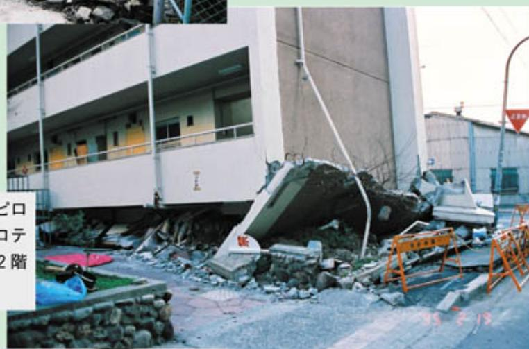
写真5 RC造ラーメン構造の駐車場ピロティ型マンション。1階の駐車場ピロティ部分のみ完全に層崩壊している。2階以上は大きな被害がない。
