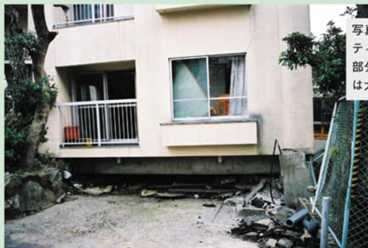
写真4 RC造ラーメン構造の駐車場ピロティ型マンション。1階の駐車場ピロティ部分のみ完全に層崩壊している。2階以上は大きな被害がない。
