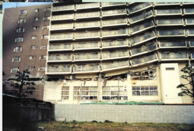
写真10 SRC造ラーメン構造の下階店舗付き・コ字型の高層マンション(10階建て)。(上写真) 1階が店舗、2~3階が事務所、4階以上が住戸で構成される用途複合型マンション。旧耐震基準の建物。コ字型の形状であるが、エキスパンション・ジョイントが設けられておらず、構造的に一体となっている。前面道路に面した南側の3階事務所部分が完全に1層分圧壊している。事務所部分の階高が高く剛性率が低かったこと、耐震壁が不足していたこと等が原因。(下写真) 東側の建物部分。エキスパンション・ジョイントで建物が切り離されていないため、この部分でも3階部分の層崩壊が始まっている。
