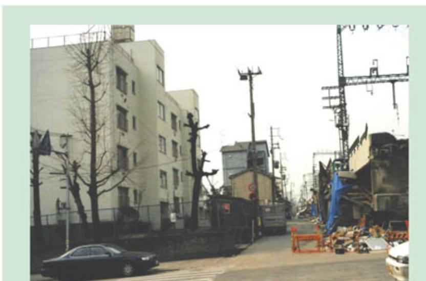
写真1 阪神・淡路大震災のケース。隣の鉄道の高架は圧壊しているが、築後30年以上経過した壁式構造の集合住宅は被害を受けていない。
