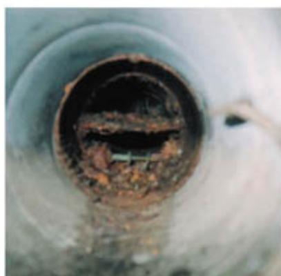
ダクトの内側から見た腐食劣化した排気孔のファイヤーダンパー。更新が必要。
