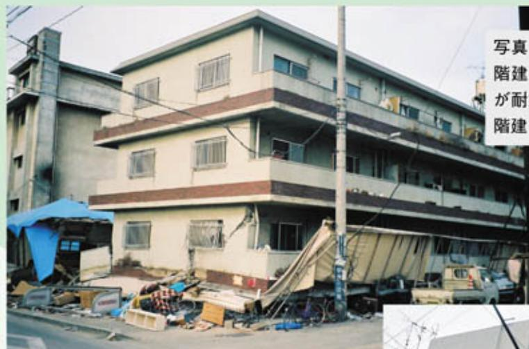
写真7 1階が店舗・2階以上が住戸の4階建てマンションであるが、1階店舗部分が耐震壁の不足等により完全に層崩壊し3階建てに見える。
