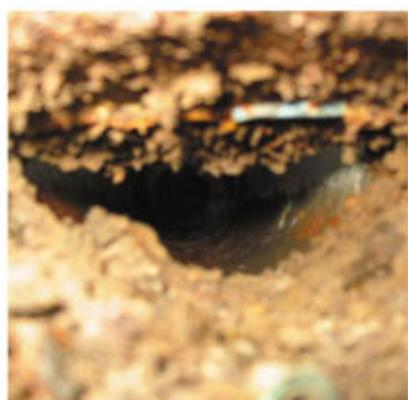
換気扇ダクト内部の塵埃などによる閉塞状況。家ダニなどの温床になります。
