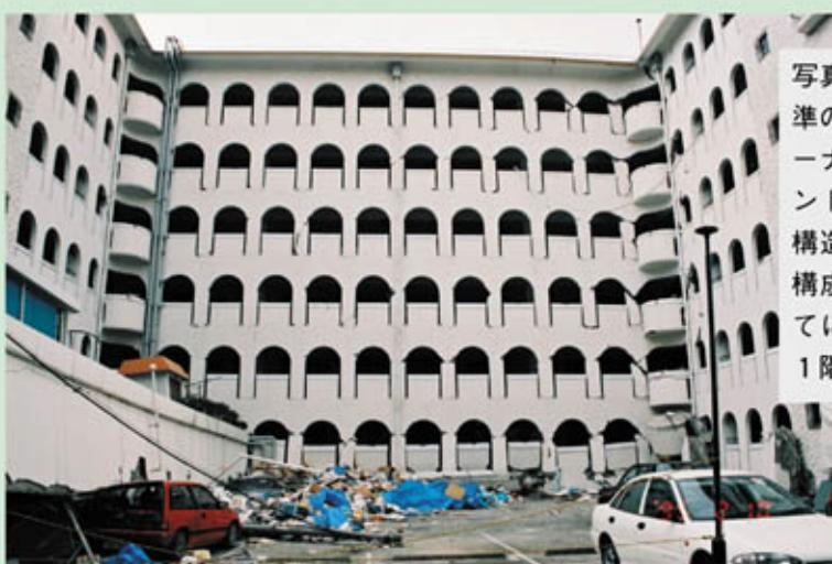
写真2 築後30年以上経過した旧耐震基準のRC造ラーメン構造のコ字型住棟。コナー部分にエキスパンション・ジョイントは設けられておらず、全体で一つの構造体。1階が店舗、2階以上が住戸で構成される用途混合マンション。6階建てに見えるが、元は7階建ての建物で、1階が完全に圧壊している。
