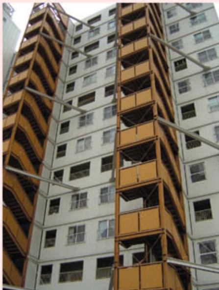
写真15 鉄骨階段の踊り場に丸鋼プレースによる補強と、屋外階段は3層おきに鉄骨水平杖を設置して構造躯体に緊結。
