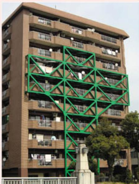
写真16 6～8階部分の補強として、バルコニー外側に基礎から鉄骨プレースを立ち上げ補強を実施。
