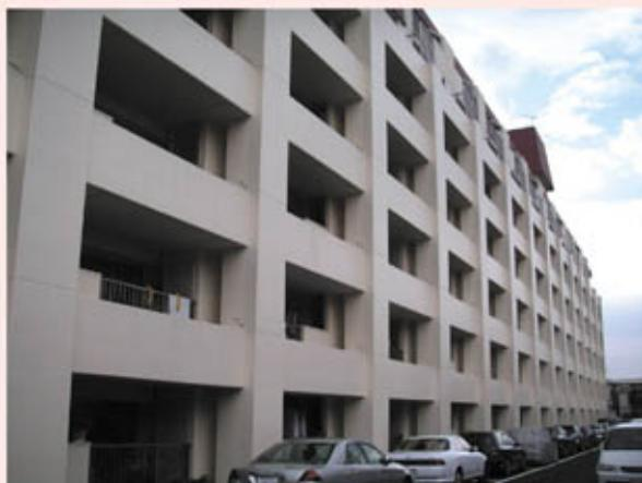
写真5 長辺方向の強度と粘り強さを高めるため、建物外壁の外側にRC造のフレーム（ブレースのいらない柱・梁の枠組み）を新設。
