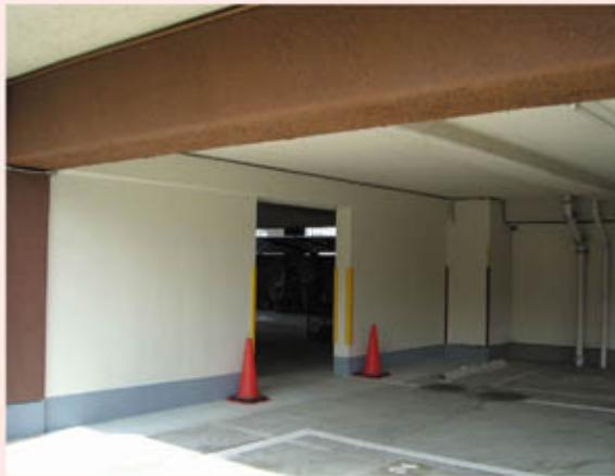
写真17 ビロティの独立柱の間に耐震壁を新設。駐車場台数は手前の2台のみに減少。
