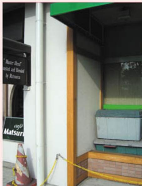
写真6 ピロティ部分の独立柱の靱性補強の事例：炭素繊維シート巻き補強（炭素繊維シート巻き補強は、開口部に接した柱への施工も可能）。
