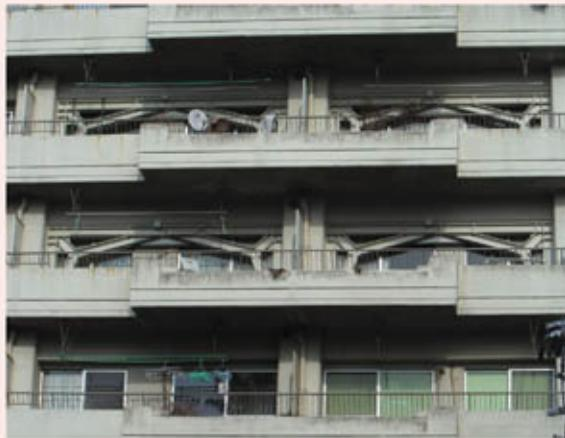
写真18 5～6階部分でバルコニー側開口部の外付け鉄骨プレース補強。出入りに極力支障のない形のプレースを採用している。
