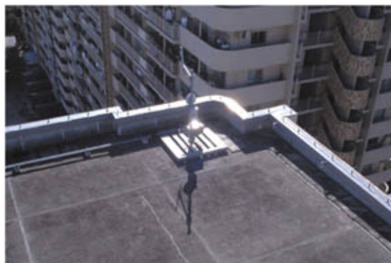
屋上に設置された構内無線方式の親アンテナ。各戸の子アンテナで受信して高速インターネット環境に接続する
