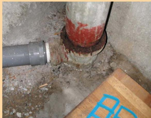
台所系排水管の継手ねじ部の傷み
