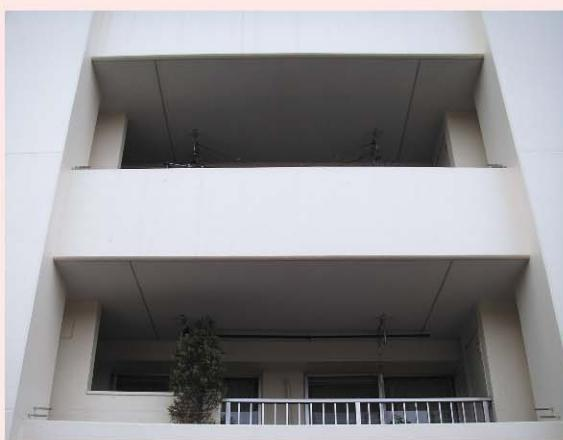
写真7 ブレースがないため、専有部分の採光、眺望、バルコニーの使用性などが確保されている。
