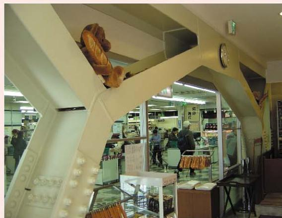
写真2 1階店舗の強度型補強の事例：鉄骨プレース補強。
