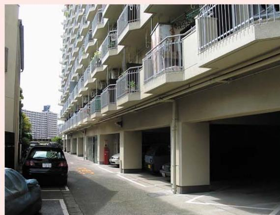
写真10 1階ピロティ部分の独立柱に炭素繊維シート巻き付け補強を実施。
