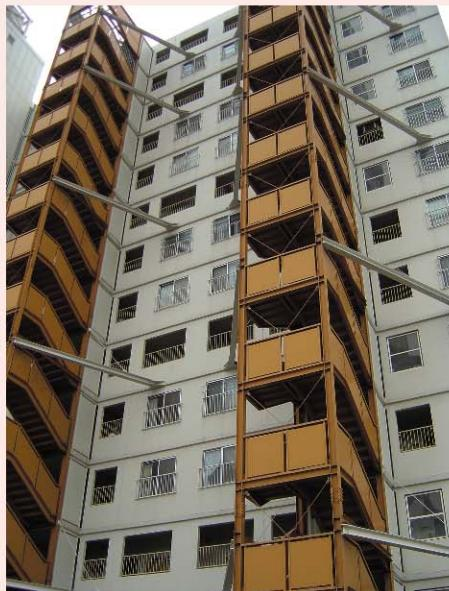
写真15 鉄骨階段の踊り場に丸鋼プレースによる補強と、屋外階段は3層おきに鉄骨水平方杖を設置して構造躯体に緊結。
