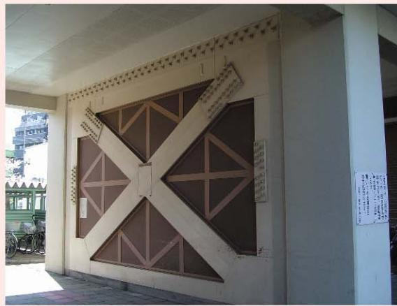
写真4 1階ピロティ部分の独立柱間に鉄骨プレースによる耐震壁の新設。
