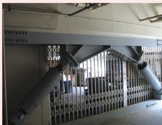
写真11 1階ピロティ部分の柱・梁間に設置した制震ダンパー(200t)。
