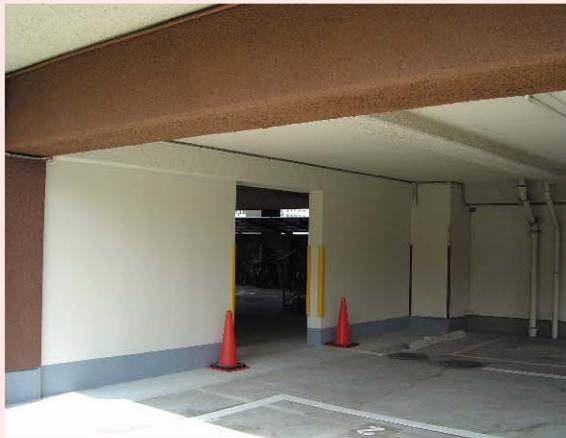
写真17 ピロティの独立柱の間に耐震壁を新設。駐車場台数は手前の2台のみに減少。
