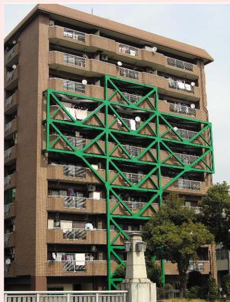
写真16 6～8階部分の補強として、バルコニー外側に基礎から鉄骨プレースを立ち上げ補強を実施。
