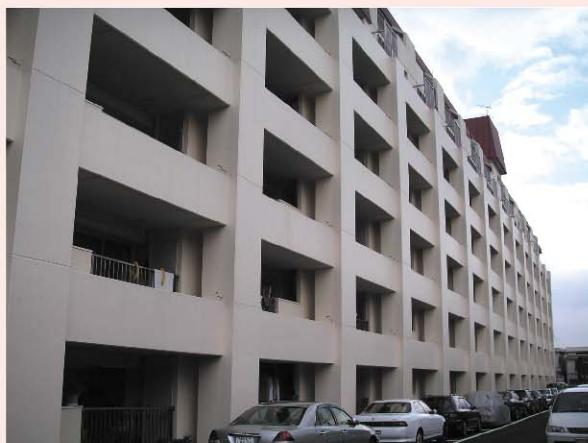
写真5 長辺方向の強度と粘り強さを高めるため、建物外壁の外側にRC造のフレーム（ブレースのない柱・梁の枠組み）を新設。
