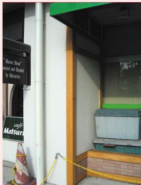
写真6 ピロティ部分の独立柱の靭性補強の事例：炭素繊維シート巻き補強（炭素繊維シート巻き補強は、開口部に接した柱への施工も可能）。
