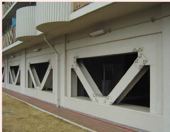
写真1 1階ピロティ部分に鉄骨プレース設置による強度補強。
