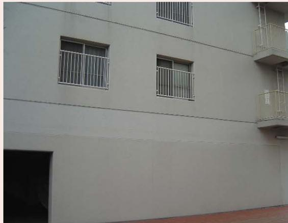
写真14 1階ピロティの短辺方向(妻側)はピロティ柱間に耐震壁を新設。
