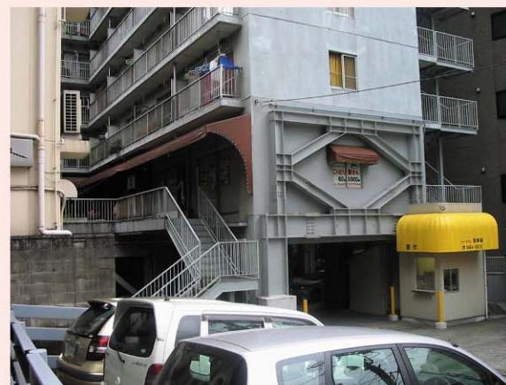
写真8 駐車場出入口部分の鉄骨フレーム補強。
