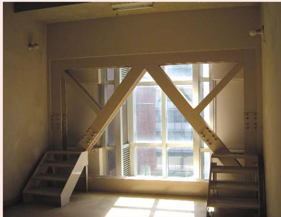
写真13 4階コモンルームの開口部の鉄骨プレース補強。
