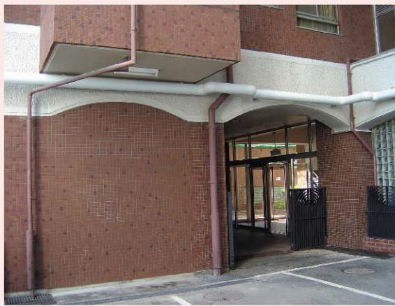
写真3 1階ピロティ部分の独立柱間(写真の左半分)の柱間にRC造を新設。
