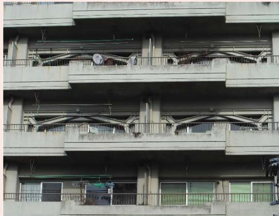
写真18 5～6階部分でバルコニー側開口部の外付け鉄骨ブレース補強。出入りに極力支障のない形のブレースを採用している。
