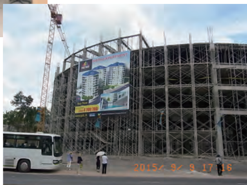
メトロ・アパートメント現地案内所*と建設現場
