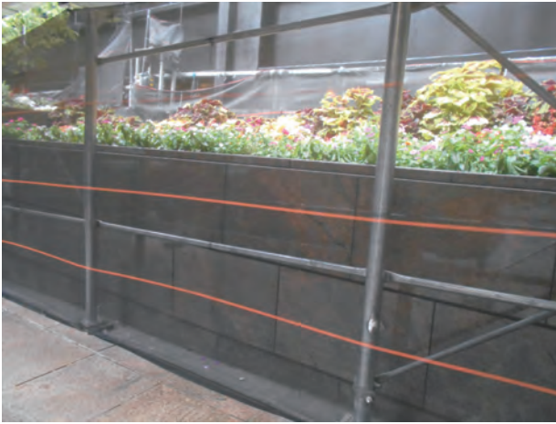
写真⑦ マンハッタン、ダウントウン地区のビル改修現場にて（2015年に筆者が撮影）
