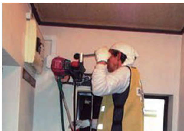
住戸内コンクリート壁を鉄筋探索後コア抜き（組合承認事項）
