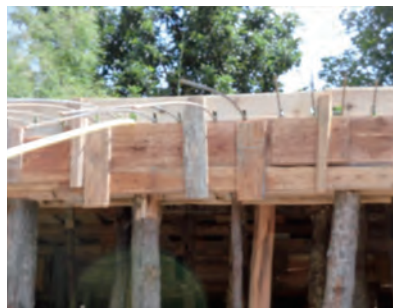
通常の建築物 RC 柱梁。壁はレンガ積み(型枠支保工がヤシの木で適当に・・・)。右は型枠の様子*
