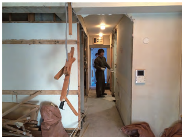
専有部分の解体工事。廃材を搬出するルートはバックヤードを経由するように
