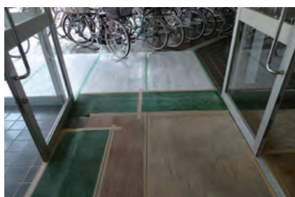
エントランス(玄関)回り
