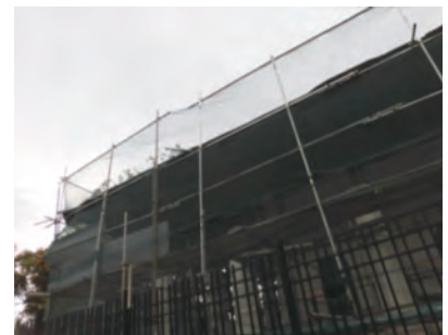
改修現場の足場。単管シングル。メッシュシートではなく網目の粗いネット張り(キャンディ) *
