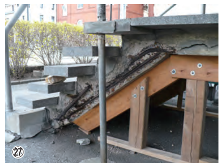
写真②⑤～②⑦ Begrisch Hall 躯体の不具合(鉄筋曝露、補修跡の再発、2008年に筆者が撮影)
