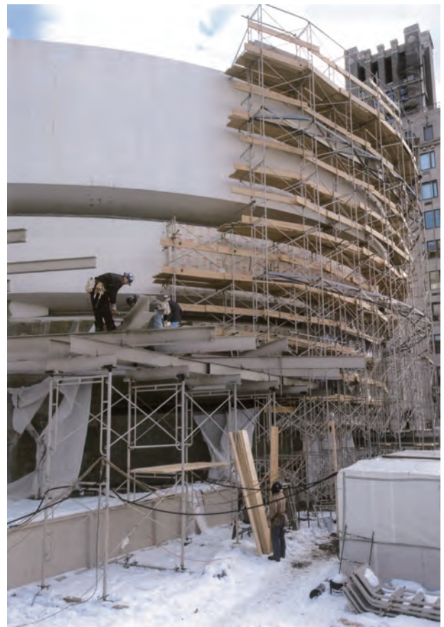
写真⑤ グッゲンハイム美術館改修時の足場設置状況（2005年、グッゲンハイム美術館50周年記念誌より）
