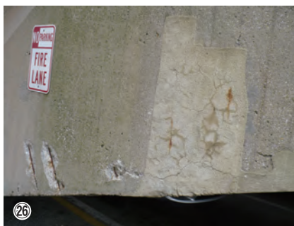
写真②⑤～②⑦ Begrisch Hall 躯体の不具合(鉄筋曝露、補修跡の再発、2008年に筆者が撮影)
