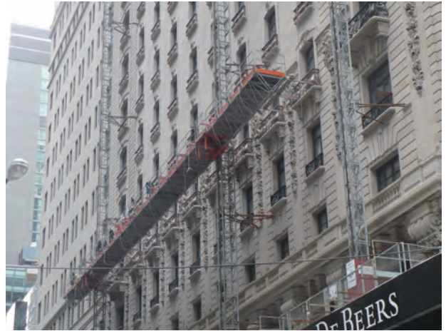
写真⑨ マンハッタン、ミッドタウン地区にあるホテルの外装補修現場にて（2010年に筆者が撮影）
