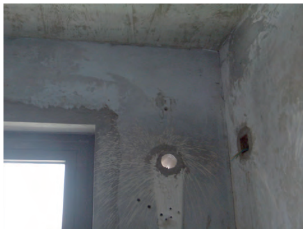
あとからコア抜きするときには鉄筋を切断しないように注意する
