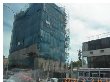
市内建設中の物件
