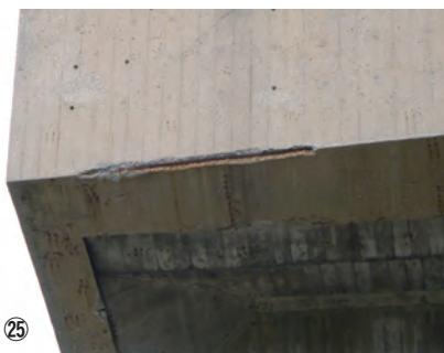
写真②⑤～②⑦ Begrisch Hall 躯体の不具合(鉄筋曝露、補修跡の再発、2008年に筆者が撮影)
