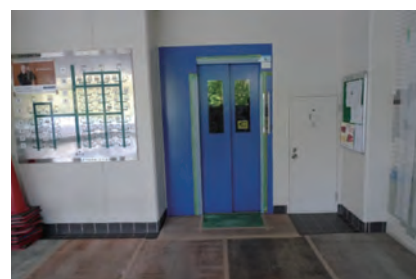
エレベーター回り
