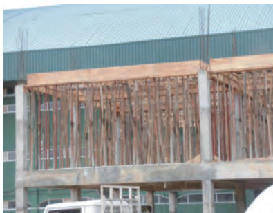
通常の建築物 RC 柱梁。壁はレンガ積み(型枠支保工がヤシの木で適当に・・・)。右は型枠の様子*
