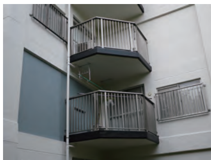
写真⑧ バルコニー手摺改修後
