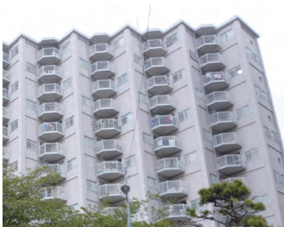
【改修前の全景】
