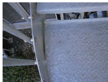
写真19 ササラ桁と縦格子ルーバー間にパッキンを挟みボルト接合
