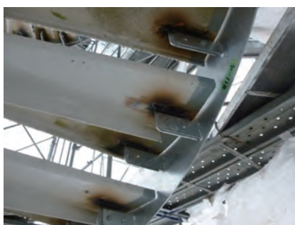
写真18 溶融亜鉛メッキササラ桁を塗装の踏板裏の2点支持でボルト接合
