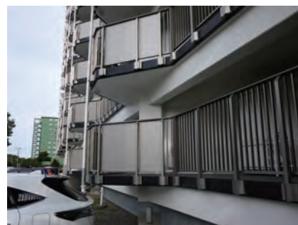
写真⑥ 廊下側手摺改修後（支持金物が外観のアクセント）
