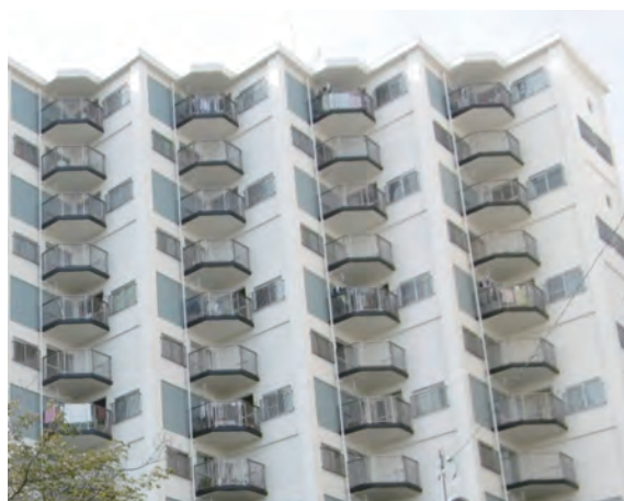
【改修後の全景】
