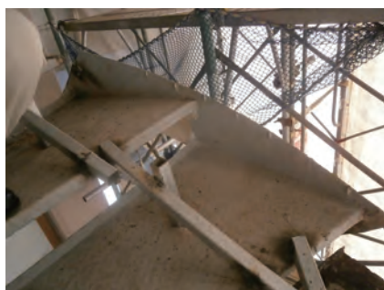
写真17 ササラ桁撤去状況（踏板どうしをつないで仮補強）
