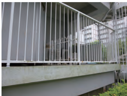
写真⑤ 廊下側手摺改修前の状況
