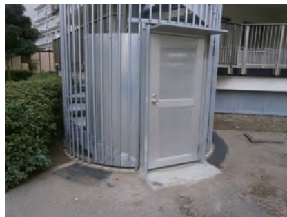
写真⑮ 螺旋階段 1 階入口扉を小庇付き形鋼建具枠にパンチングパネル扉に改修
