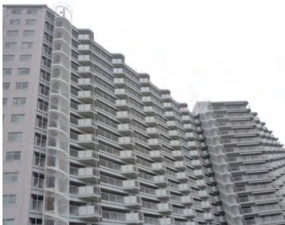
【改修前の全景】
