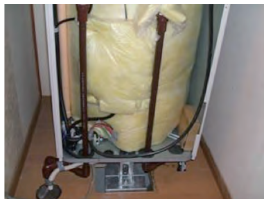
基礎に温水器を設置固定
