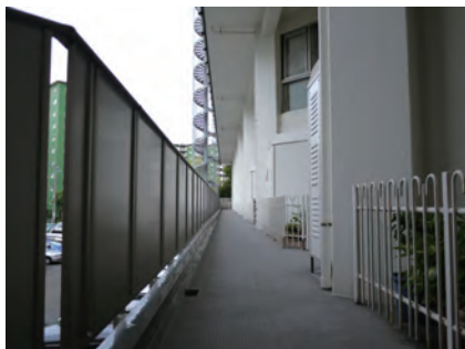
写真⑪ 廊下支柱外付けで廊下幅が広がった効果を生む
