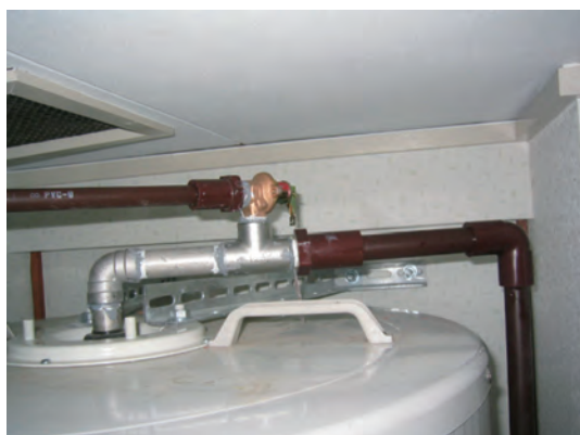
電気温水器の上部に転倒防止金物を取り付け、鉄筋コンクリートの壁（躯体）にボルト固定した。
