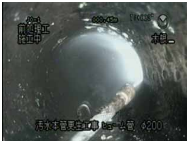
写真2 管内清掃状況
