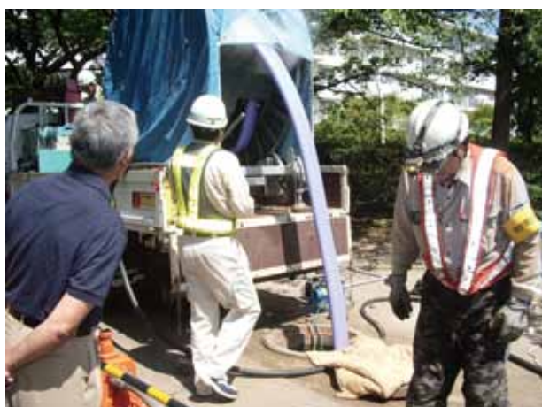
写真3 形状記憶塩ビ管パイプ挿入状況
