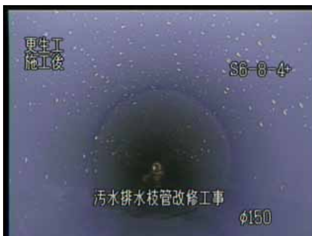
写真4 管内更生状況
