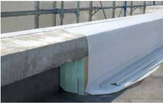
改修前 (立上り部)
