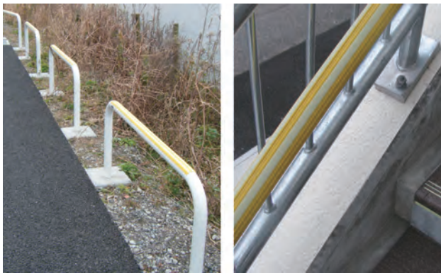
手摺を光らせることで、要配慮者が安全に避難することが可能。金属製手摺の冷たさ緩和にも役立つ。
