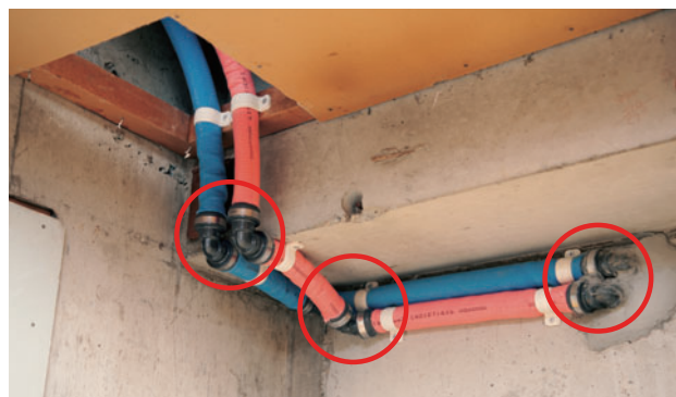
写真2 リフォーム時の配管
