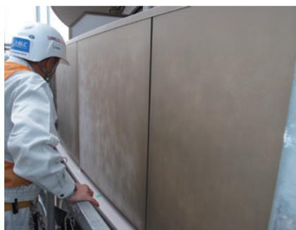
⑯ 被膜の薄いアルミパネルの塗膜が劣化し下地が露出、予算が足りずパネルの塗装などは次回へ持ち越し
