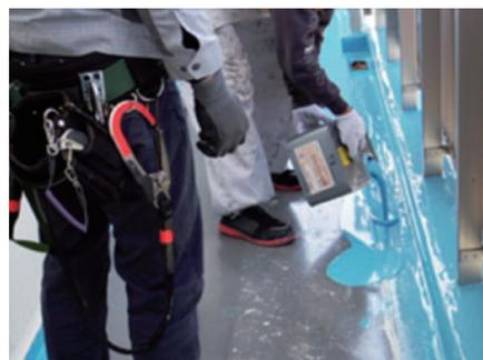
蓋を開け、材料を供給後、蓋を閉め戻すだけ
