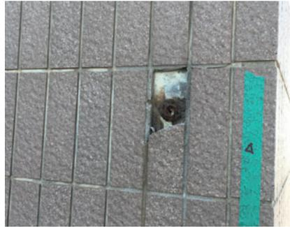
⑧グラウト注入口金が腐蝕膨張しタイルが割れ落ちている個所
