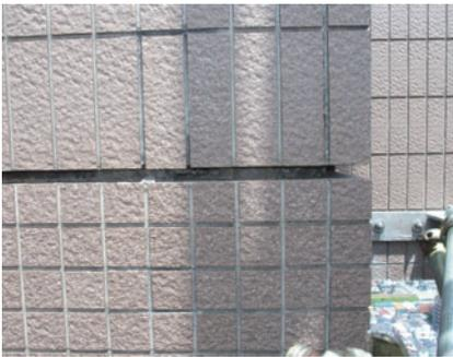
④PCa パネルゾーンと柱取合い露出目地のシール打ち忘れ
