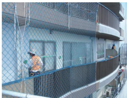
⑬ アクリルゴム系外壁化粧防水材の施工中、工程が多いため時間と手間がかかる
