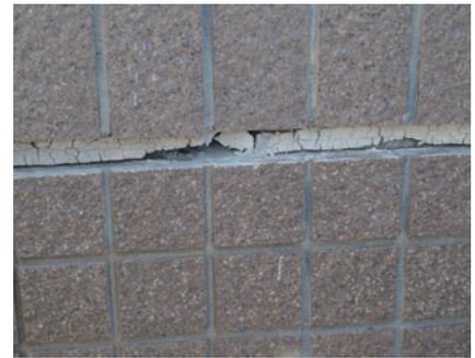
⑥躯体のプレキャストピース取合い露出目地シーリングの劣化が激しい個所。完全に破断し漏水の懸念もあるような状態。
