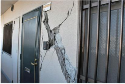
非構造壁でも、壊れれば目立ち、雨が掛かる外壁なら雨漏りに繋がります。混乱が落ち着いたら、速やかに復旧工事を行います。
