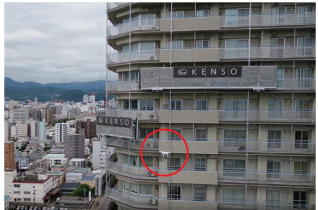
写真4 足場の無い高層マンションでのドローンによる施工状況の確認
