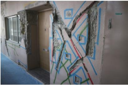
写真6 大きくひび割れた非構造壁の復旧工事
