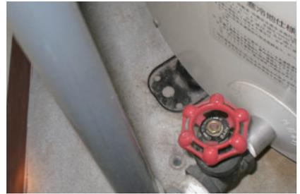
電気温水器の脚がボルトで固定されているか確認しましょう。特に奥の脚は固定されていないことが多く注意が必要です。固定されていない電気温水器は、地震で移動し、配管が折れ温水流り出る恐れがあります。
