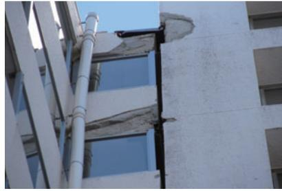
写真2 エキスパンションジョイントの離隔不足による外壁の破損・剥落
