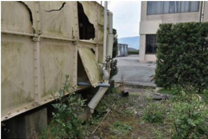
受水槽が耐震仕様になっているか、配管の固定方法や変位吸収継手が適切に設置されているか確認しましょう。
