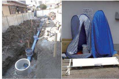
写真左は災害用屋外トイレの工事状況です。災害時は写真右のように簡易トイレテントで囲います。
