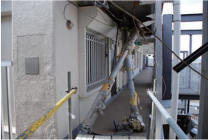
写真3 エキスパンションジョイントを渡る給水横主管の破損
