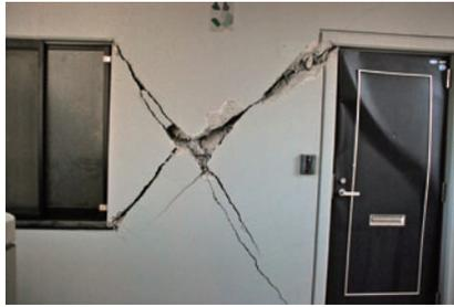
写真7・8 非構造壁の復旧と共に、玄関ドアなど二次部材も更新した事例。復旧前(左)、復旧後(右)
