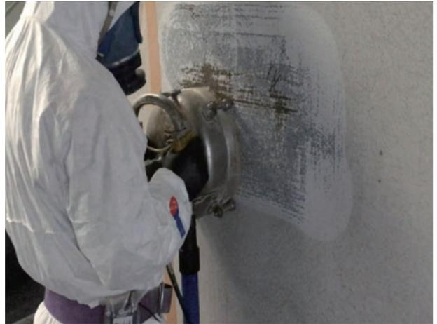
写真 13 集じん装置付き超高压水洗工法 (100Mpa 以上)
