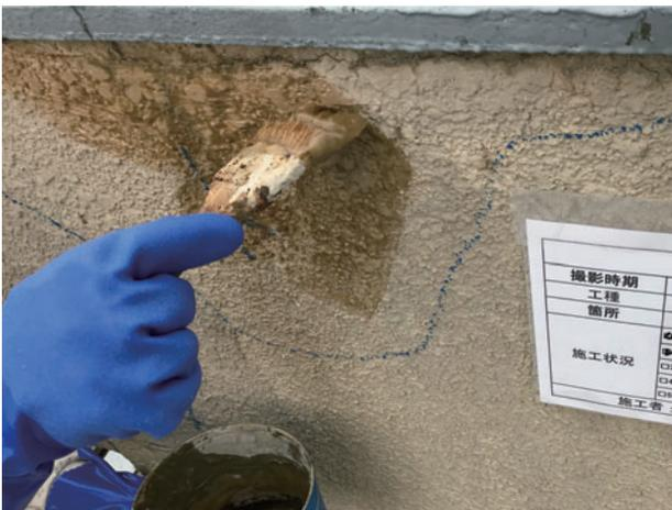
写真3 脆弱塗膜部除去・塗膜剥離剤塗布状況
