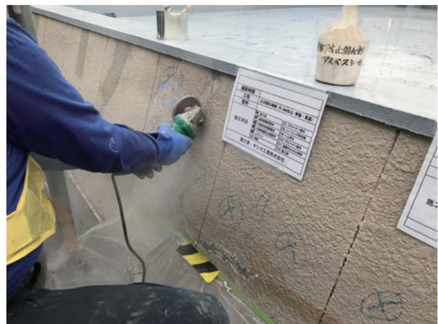
写真9 Uカットシール工法・塗膜除去後、U字溝新設
