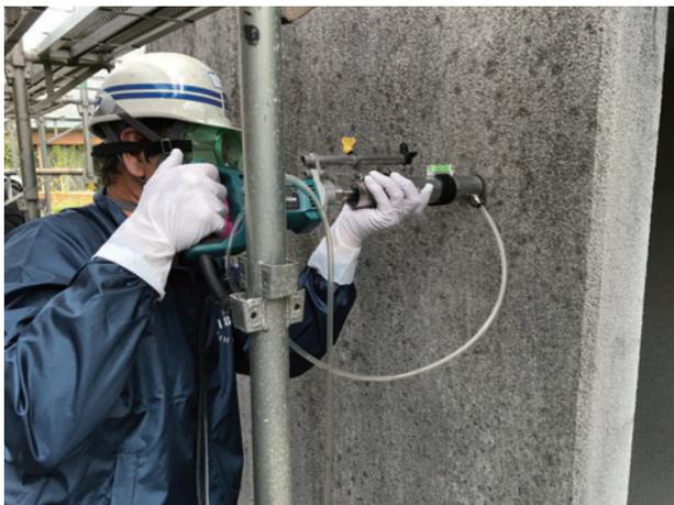
写真7 穿孔・水循環式無振動ドリル
