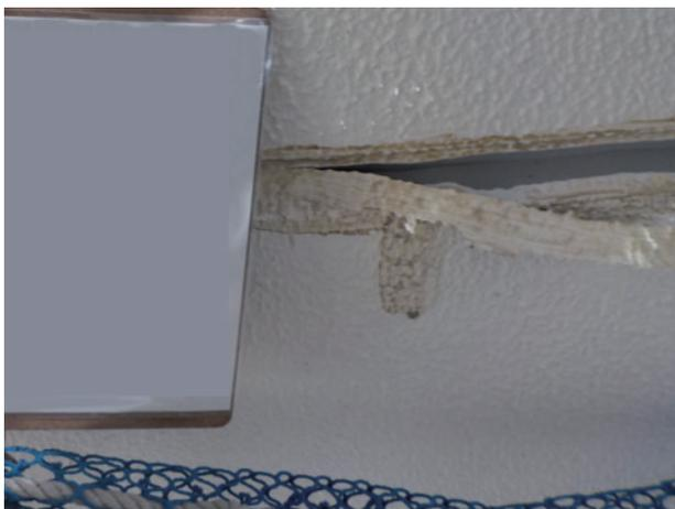
写真10 既存シーリング材撤去・塗膜剥離剤にて塗膜除去
