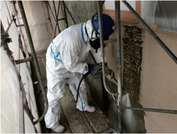
写真 12 剥離剤併用高圧水洗工法 (30 ~ 50Mpa)
