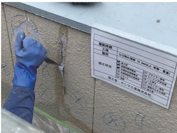
写真8 Uカットシール工法・U字溝部、塗膜除去
