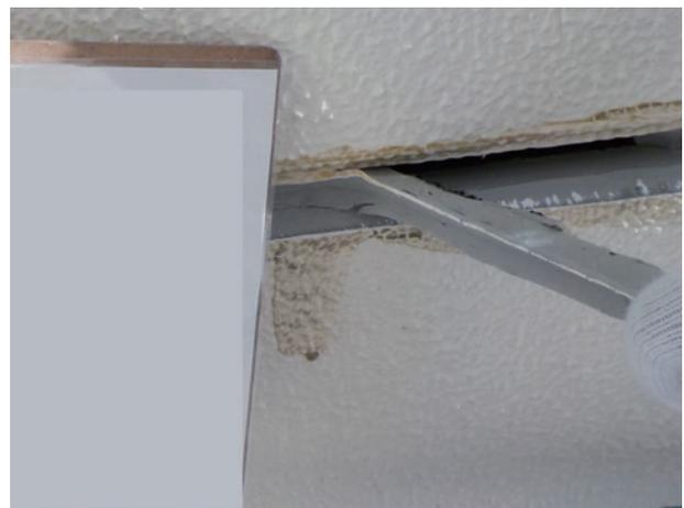
写真11 同・既存塗膜除去後にシーリング材撤去
