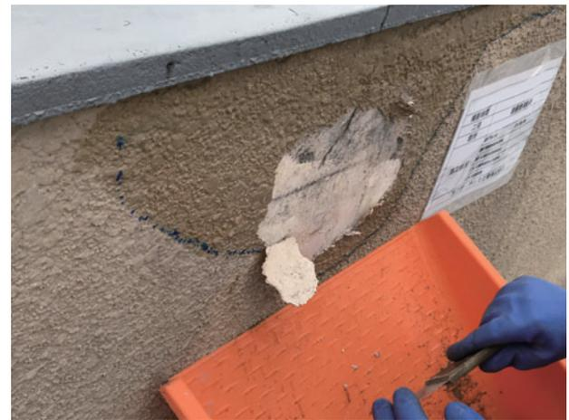
写真4 同・塗膜剥離剤併用手工具ケレン工法
