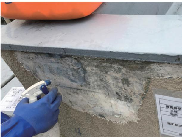
写真5 同・既存塗膜除去後、飛散防止剤噴霧
