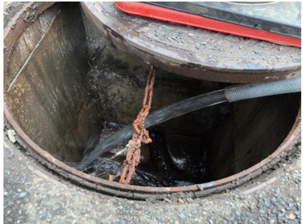
写真 15 水処理後、下水に排水
