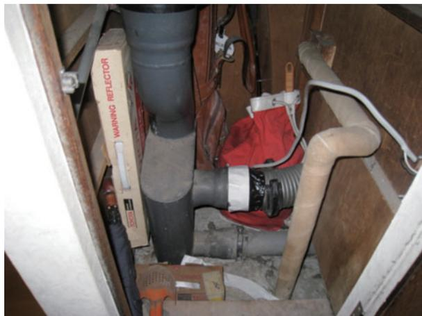
写真9 改修前の二段口継手（ソベント継手）
