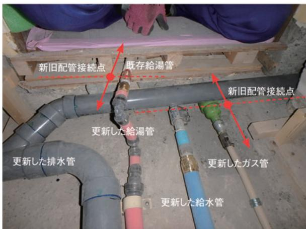
写真 12 専有部分のやり残しを明確化する
