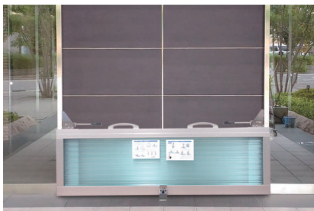
写真 5 軽量パネル止水板
