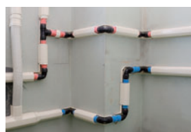
写真2 リフォーム時の配管
