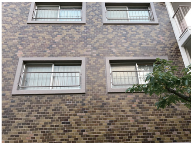
写真6 妻壁詳細 磁器タイルの上に防水クリアー塗装
