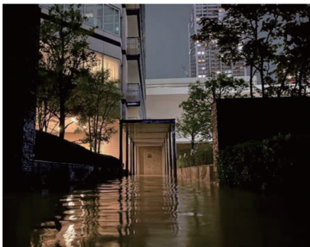
写真1 2019年台風19号で冠水したマンションの敷地
