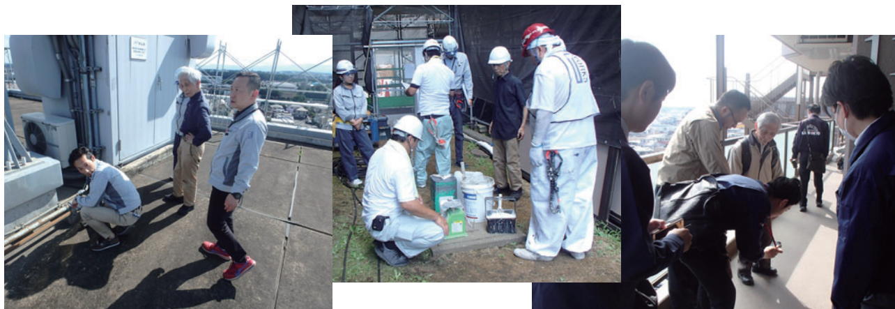
埼玉県のマンション改修現場で
