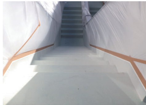
写真3 飛散防止養生の例
