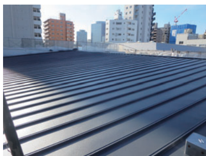
写真4 金属屋根施工例
