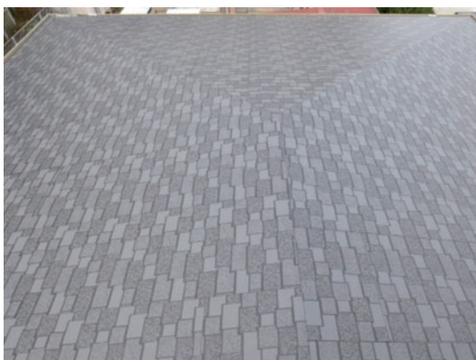
屋上斜屋根グレー色
