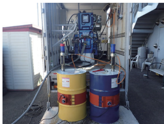
写真2 吹付け機械(作業車)の例
