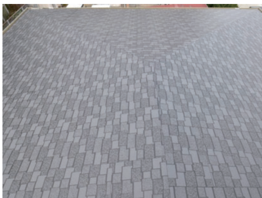
屋上斜屋根グレー色
