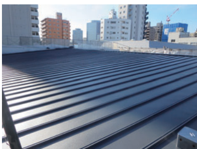
写真4 金属屋根施工例
