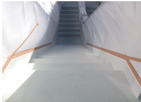
写真3 飛散防止養生の例
