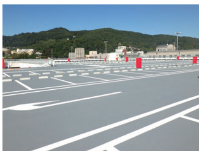
写真5 屋上駐車場防水施工例
