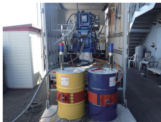
写真2 吹付け機械(作業車)の例
