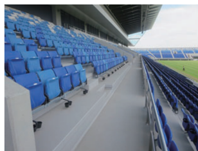
写真6 競技場観覧席防水施工例
