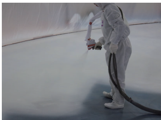
写真1 スプレーウレタン吹付け
