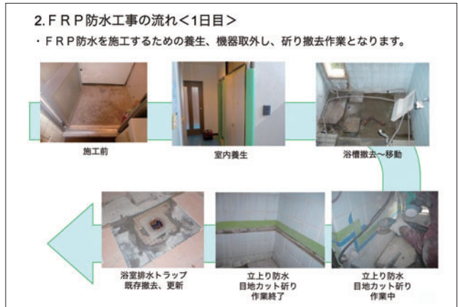
図 18 1 日目作業：露出 FRP 防水 作業場周り傷つけ防止・器具撤去・部分壊し・排水トラップ取替
