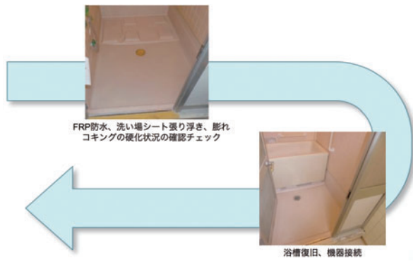
図25 7日目：露出FRP防水完了、引き渡し 検査・器具取付・確認・引き渡し
