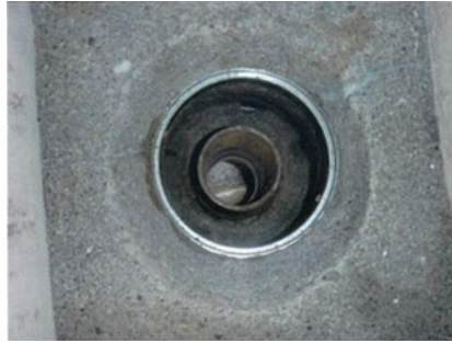
写真 26 水抜き・清掃・乾燥・研磨
