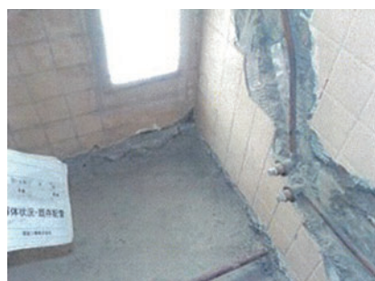
写真12 床・壁解体撤去
