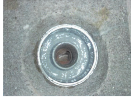
写真 27 エポキシ樹脂塗布
