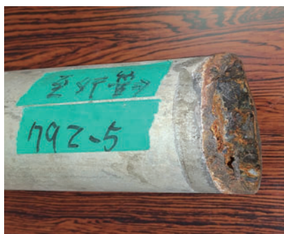
写真 5 ⑦トラップ接続部の腐蝕
