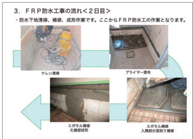
図 20 2 日目作業：露出 FRP 防水 防水下地清掃・補修・成形
