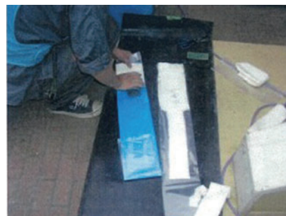
写真 33 エポキシ樹脂塗布
