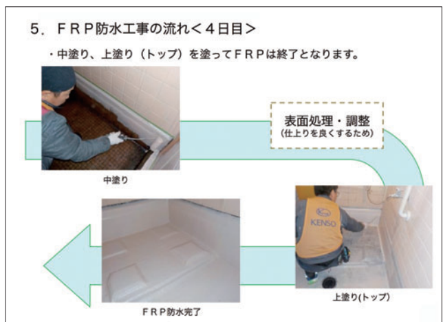
図 22 4 日目作業：露出 FRP 防水 防水中塗り・上塗り（仕上げ）
