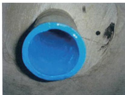
写真 38 下階排水トラップ接続管端部処理
