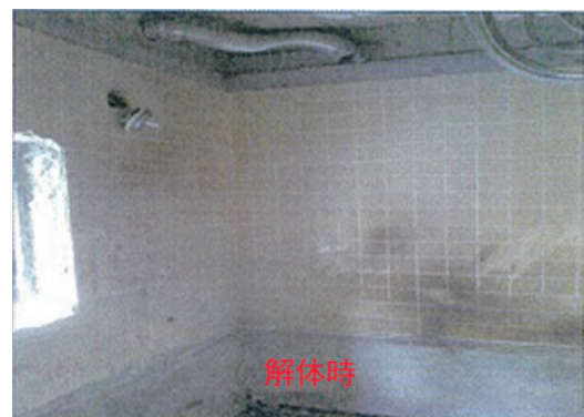
写真10 浴室内器具類・内装類撤去
