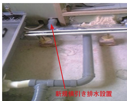
写真 14 浴室排水配管
