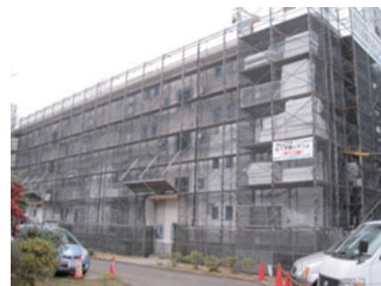
【長寿命化：築40年目にして外壁外断熱工事実施】
