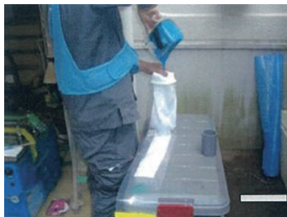
写真 32 ガラス繊維にエポキシ樹脂注入
