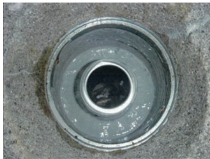
写真 29 お椀受け筒にSUS筒を差込み
