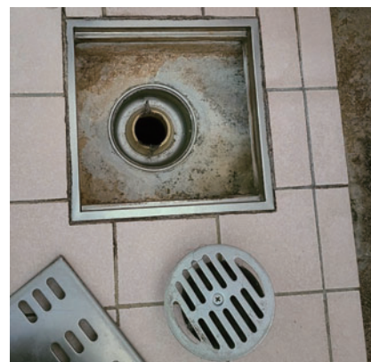
写真 3 ベルトトラップに取替え
