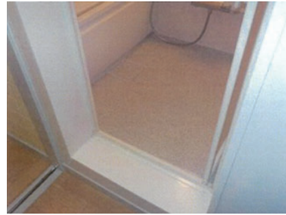
写真 24 ドア枠周り終了
