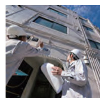
建物調査診断
