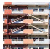
耐震診断設計工事
