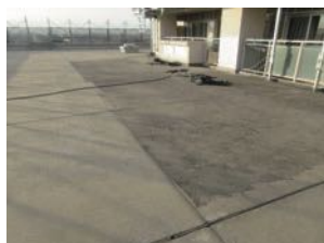
④③ 高圧水洗浄途中
