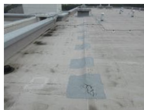
① 既存部分補修
