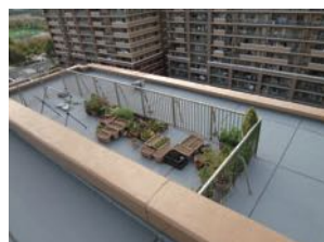
③⑤ 既存防塵塗装
