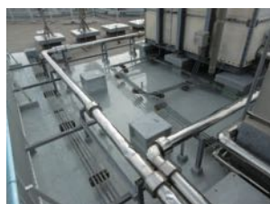
④⑨ 設備廻り
