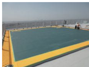
④⑪ 緊急救助用スペース
