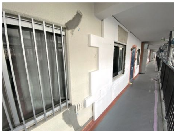
写真4 断熱ボードの張り付け
