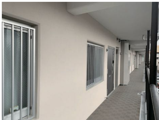
写真8 施工完了後の様子
