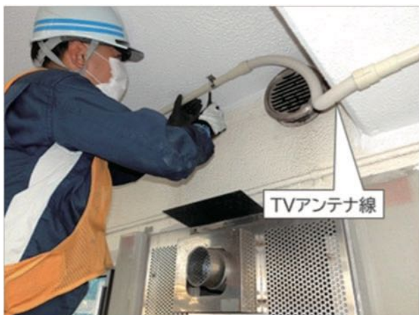
写真3 TV アンテナ線の移設状況
