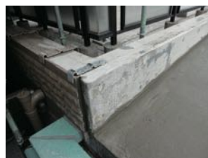
⑰ 立上り壁タイル撤去
