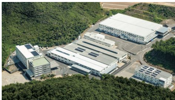
オンダ製作所関工場全景
