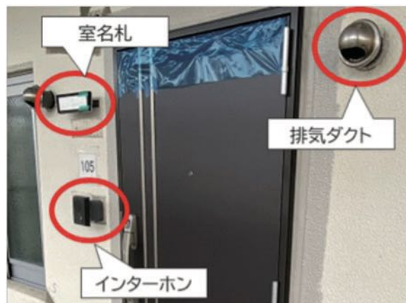
写真2 持ち出し後の外壁設置部材
