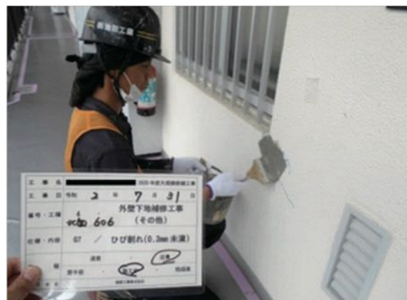
写真1 下地補修の様子
