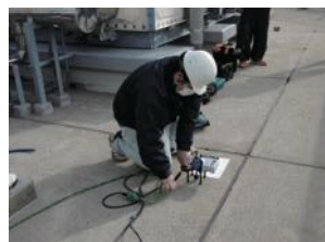
④⑥ アンカー強度確認
