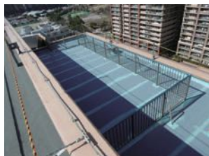
③⑤ 目地部分補強
