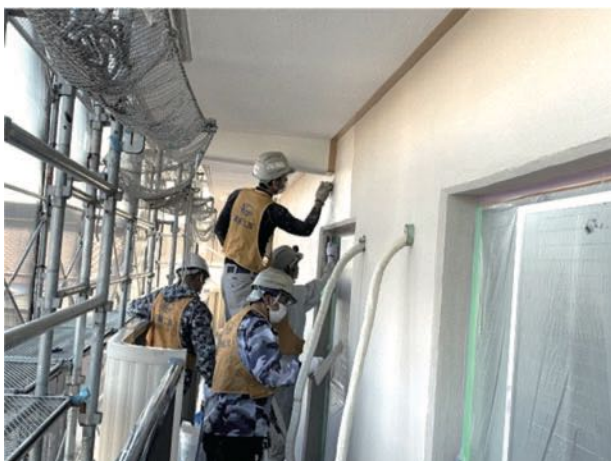
写真7 外装塗料の塗布
