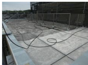
②⑨ 高圧水洗浄
