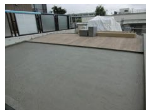
⑱ 切妻屋根修繕
