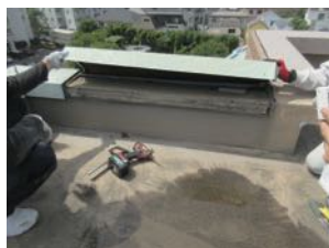
⑦ 取付け状況確認
