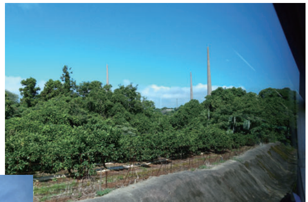
針尾送信所 移動中のバス車内より撮影
