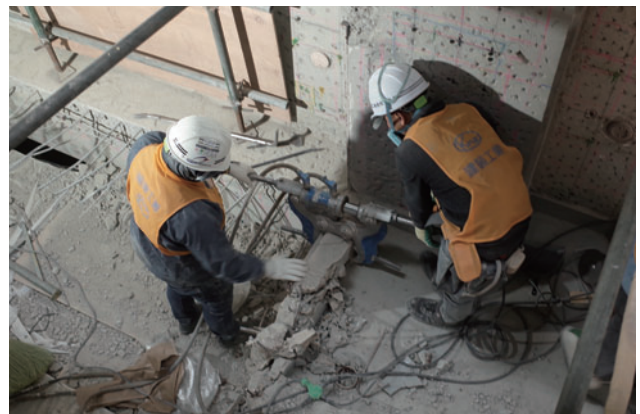
油圧工具を用いた解体
