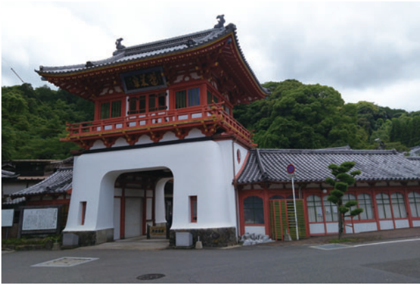
武雄温泉楼門
