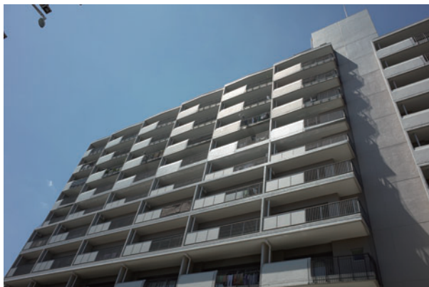
バルコニーに柱梁フレーム新設
