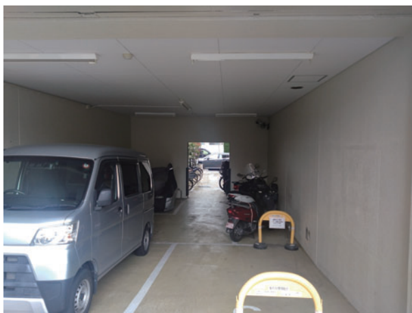
開口付き耐震壁の設置
