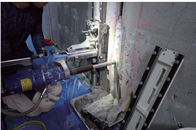
泡を用いた低騒音型の構造スリット施工
