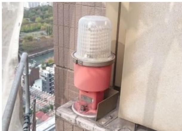
写真：航空障害灯(中間階・撤去可)
