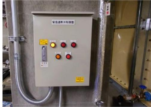
写真：制御盤 (バッテリー内蔵)
