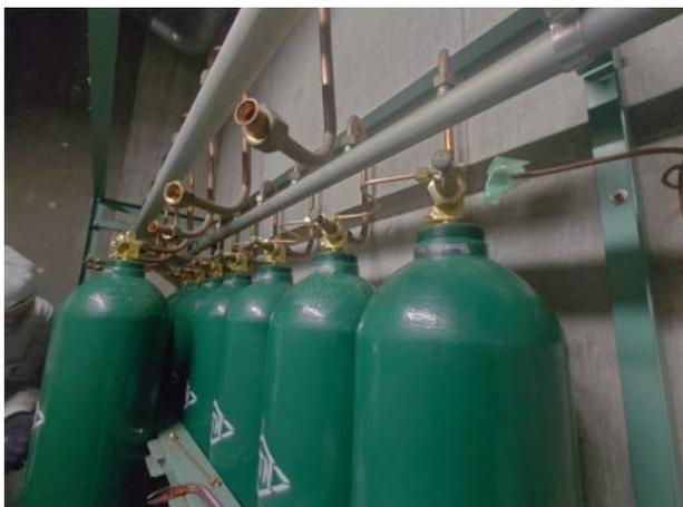
写真：二酸化炭素消火ポンベ(更新中)
