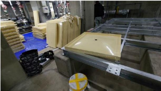
(写真) 鉄骨平架台新設、受水槽パネル設置
