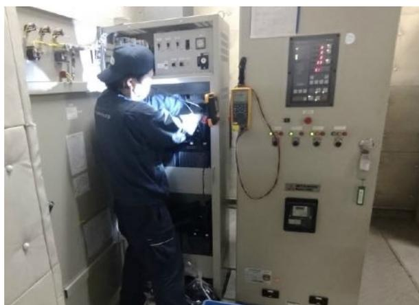
写真：発電機始動電源装置（法定点検）
