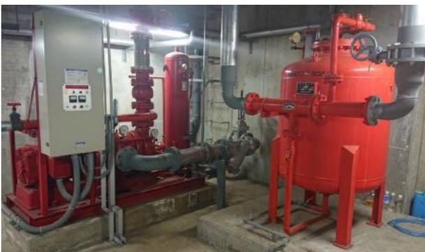
写真：泡消火ポンプ・タンク(地下機械室内)
