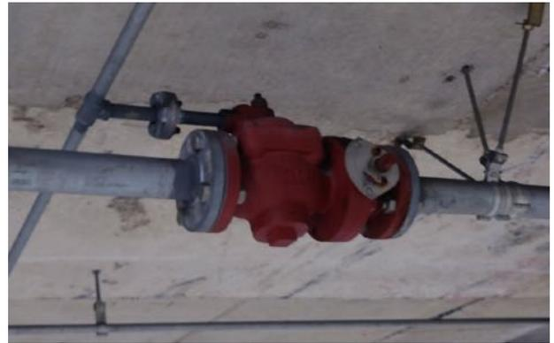
写真：泡消火一斉開放弁(地下駐車場)
