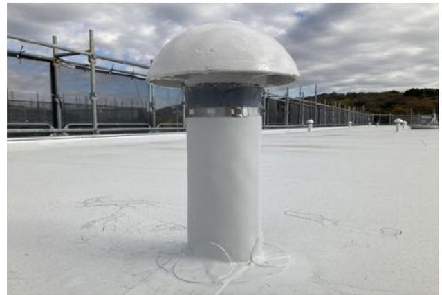
通気管は、シートを巻き上げて施工します。
