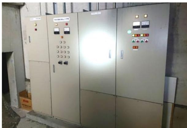
写真：航空障害灯制御盤(屋上機械室内)
