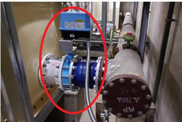
写真：緊急遮断弁
