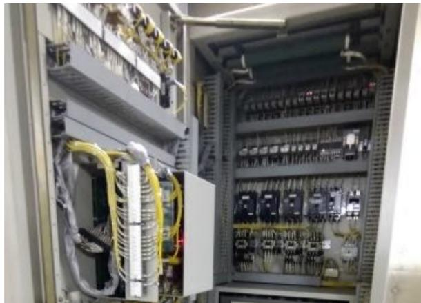
写真：発電機制御盤（法定点検）
