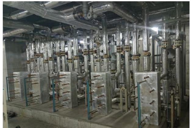
写真：1次熱交換器（機械室内）
