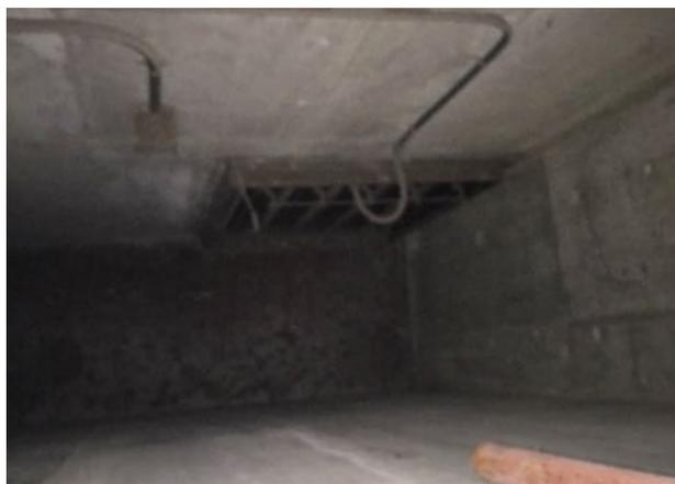
写真：排煙給気コンクリートダクト内部
