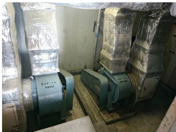
写真：排煙機(地下機械室内)
