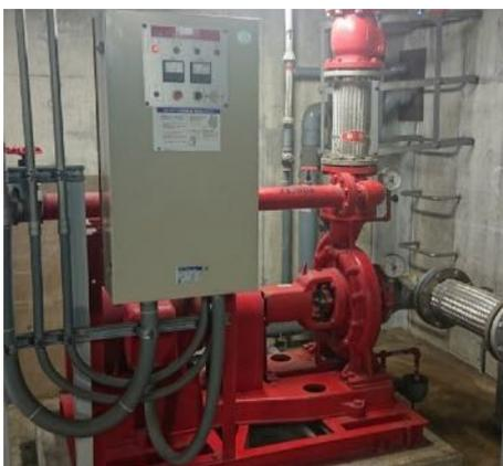
写真：採水ポンプ(地下機械室内)
