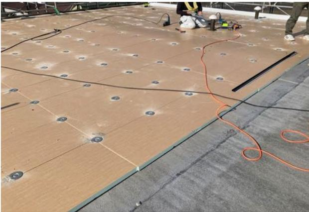
既存の防水層を撤去しないで取り付けが可能な機械的固定工法。断熱工法の採用によりエネルギー効率も改善されています。
