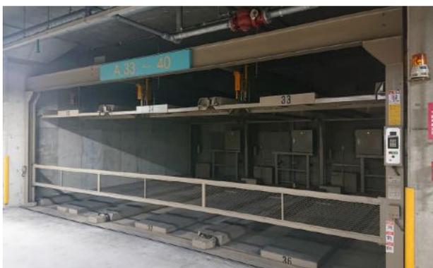
写真：機械式駐車装置・横行昇降型（地下階）
