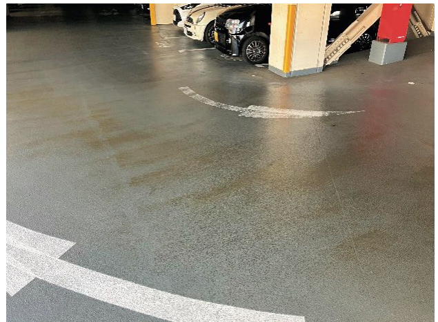
中層階の劣化例 (トップコートや骨材固着層の摩耗)
