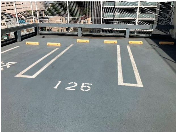
最上階の劣化例 (トップコートのチョーキング)
