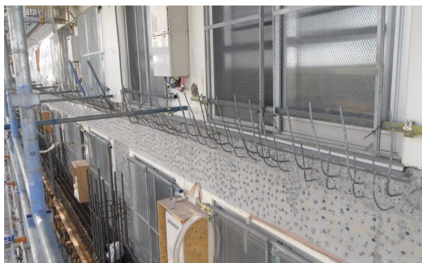
スラブ撤去後
