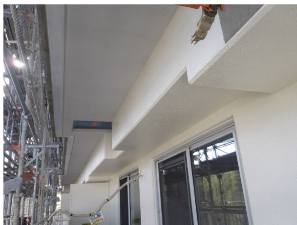
バルコニー施工後
