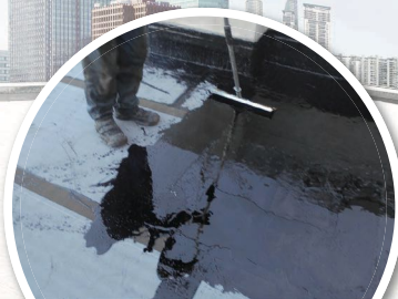
加熱型改質アス塗膜防水工法 プライムアス
