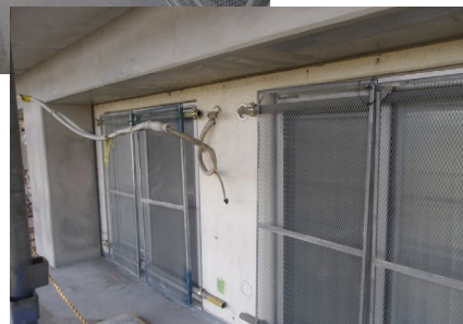
柱・梁 コンクリート 打設後
